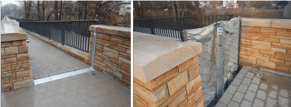
Folie-Stahl-Netz-Schutzwand „AquaWand“ an der Ems (Foto: Aquaburg)
