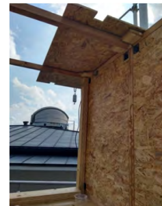
Abbildung 115 Montage neuer OSB-Beplankung
