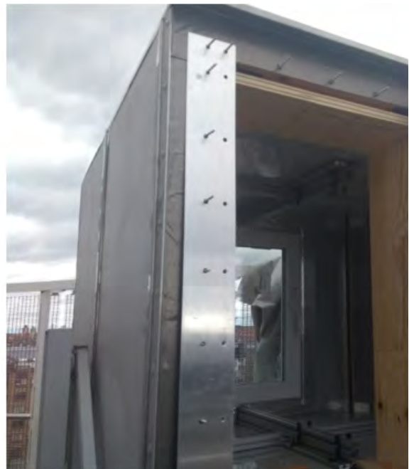
Abbildung 70 Bitumenversiegelung des Kubus (links) Bleche für den Witterungsschutz der Bauteile (rechts)
