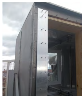
Abbildung 125 Verblechung zum Witterungsschutz
