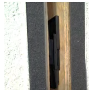
Abbildung 119 Finale Verklotzung mittels Schraubkeilen (KnieglTec)
