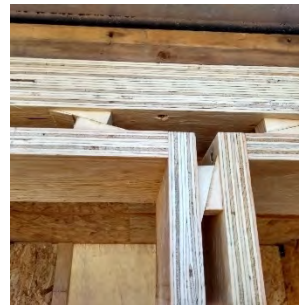
Abbildung 118 Detail der provisorischen Verklotzung
