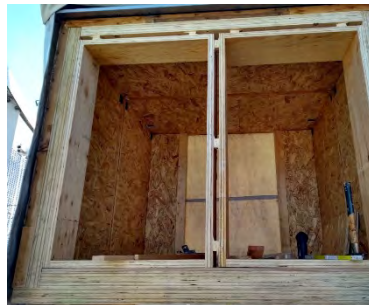
Abbildung 117 Testweises Verklotzen zweier Rahmen
