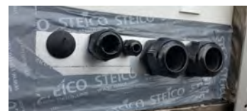
Abbildung 129 Durchführungsplatte im eingebauten Zustand (Außenansicht)
