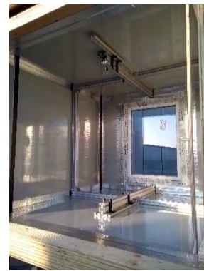
Abbildung 102 Einbau der Innendämmung und der Aluminiumprofile
