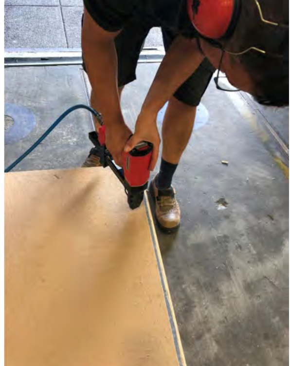
Abbildung 63 Einlegen der Holzfaserdämmung in die Holzrahmenbauwand (links) und Holzfaserplatte auf das Element (rechts)
