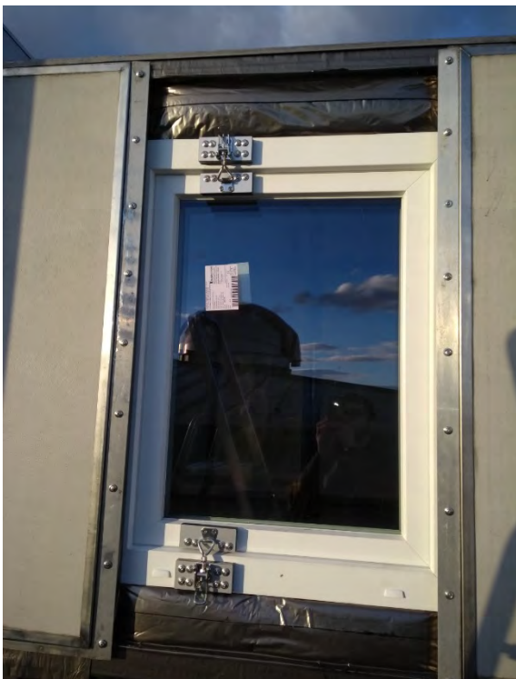
Abbildung 68: Fenster fertig eingebaut
