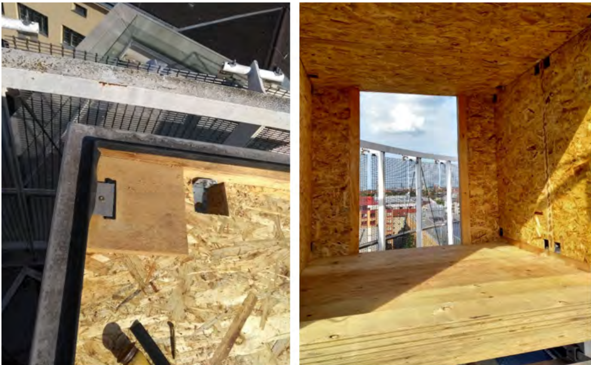
Abbildung 57 Remontage des metallenen Dachrahmens (links) und fertig beplankter Innenraum (rechts)
