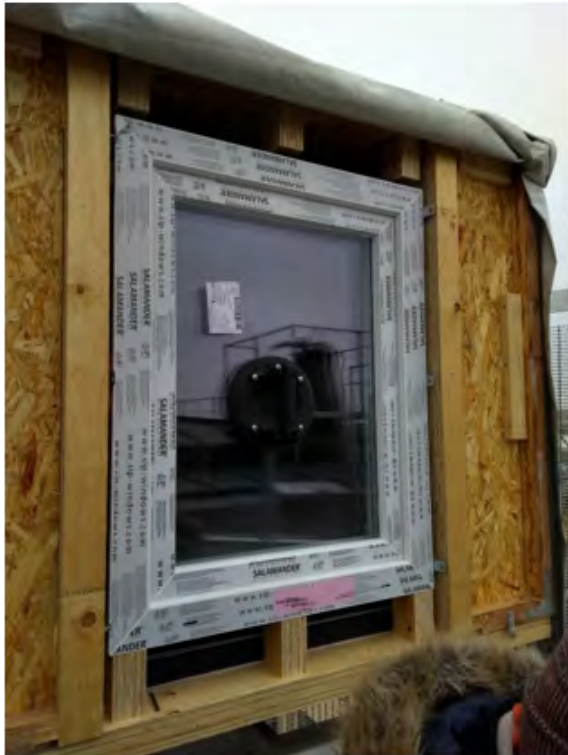
Abbildung 67 Fenstereinbau (links) Fenster abkleben (rechts)
