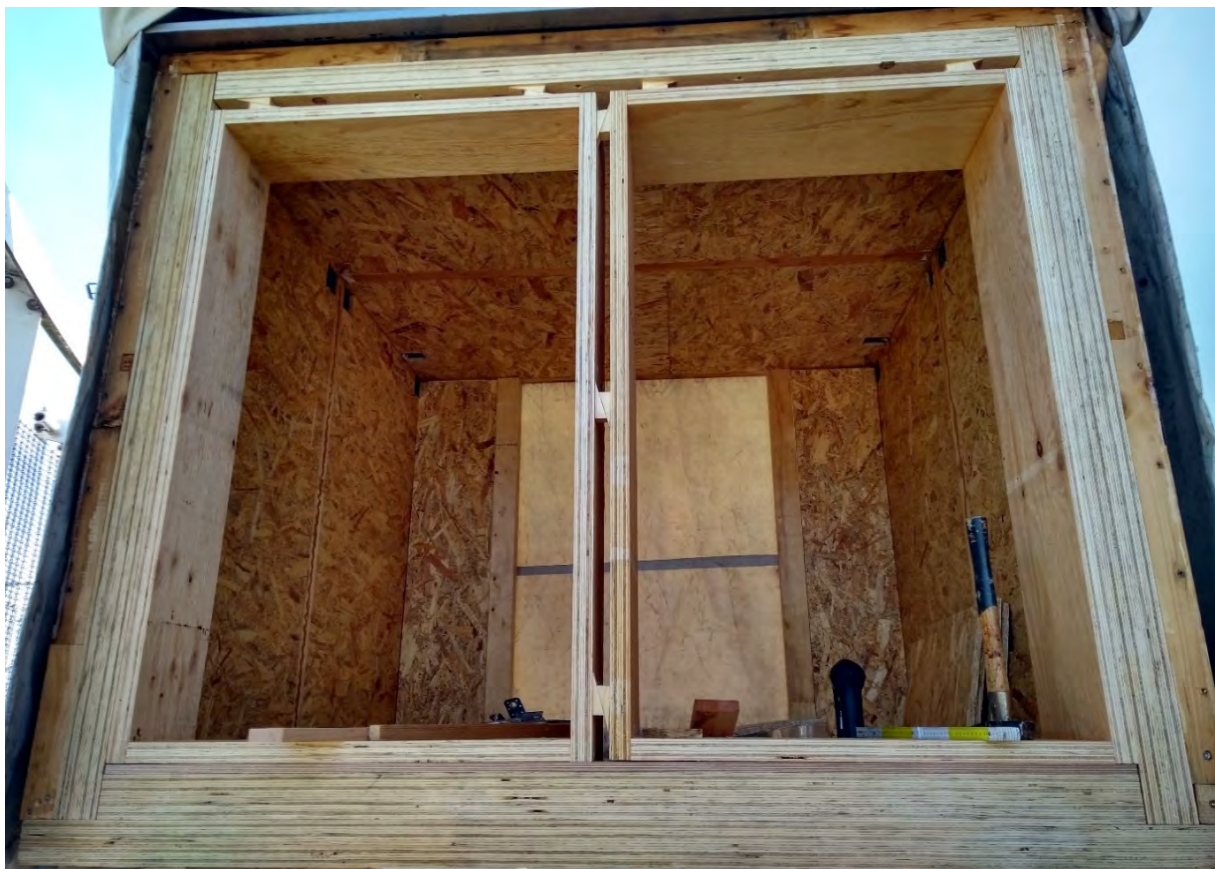
Abbildung 59 Testweises verklotzen der Rahmen (Vollbild)
