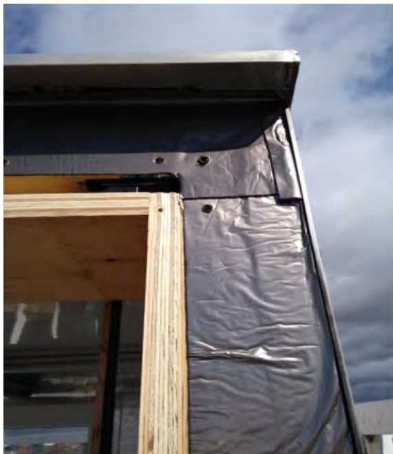
Abbildung 70 Bitumenversiegelung des Kubus (links) Bleche für den Witterungsschutz der Bauteile (rechts)
