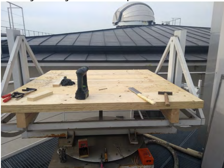
Abbildung 54 Montage der neuen Bodenplatte
