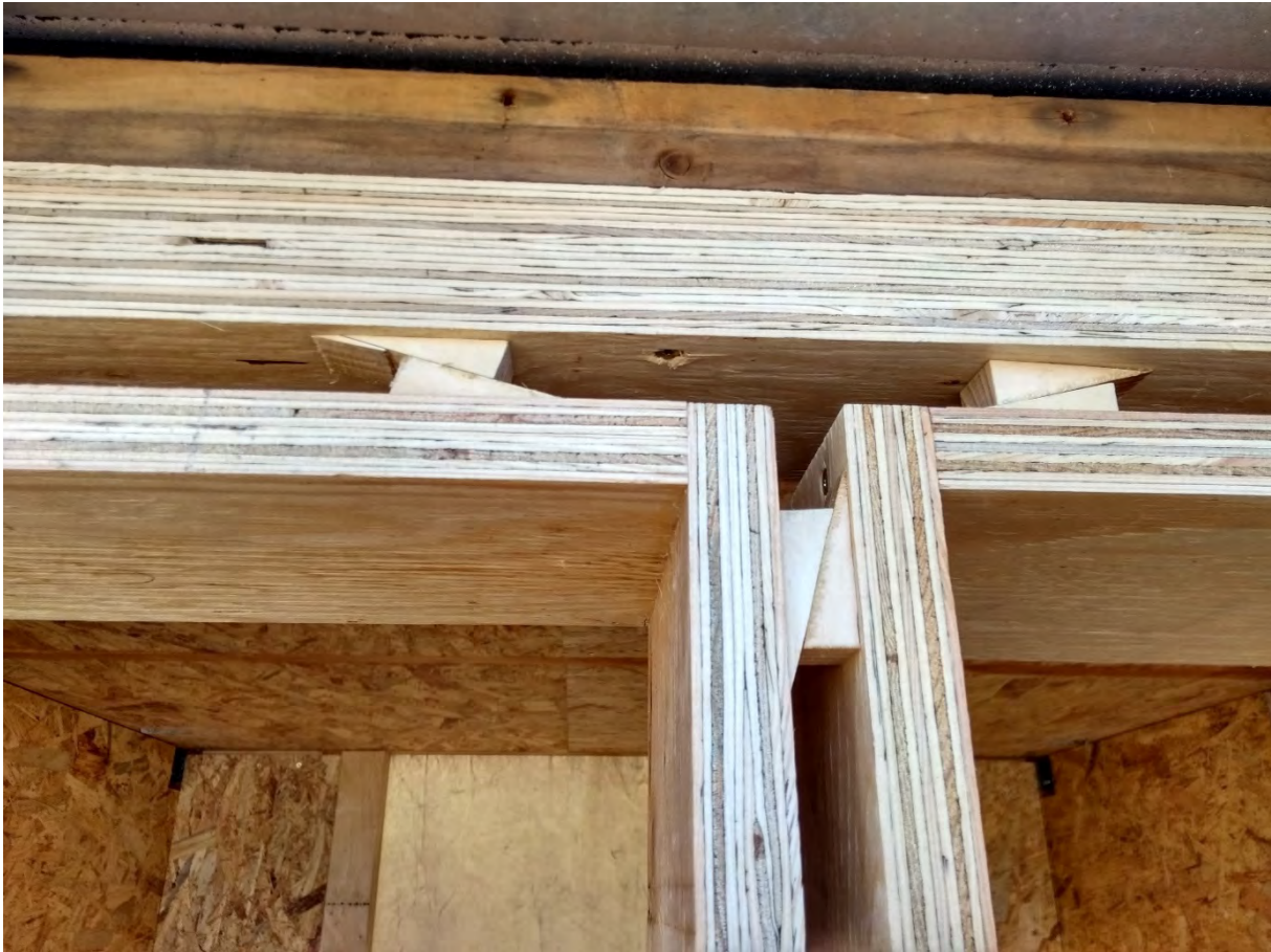
Abbildung 60 Testweises verklotzen der Rahmen (Detail)
