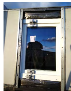
Abbildung 123 Fenster fertig abgedichtet
