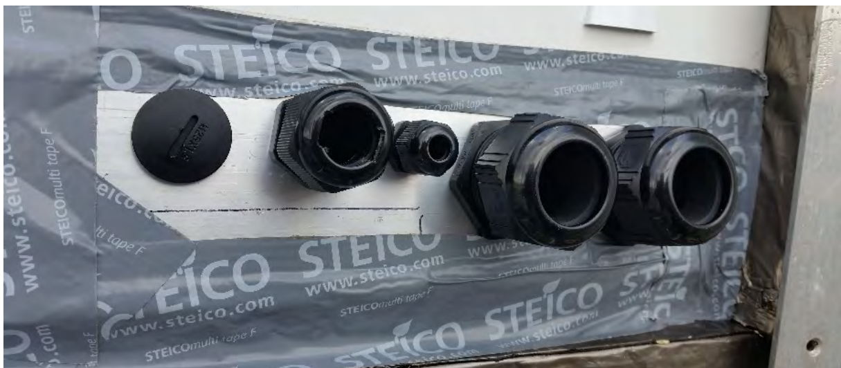
Abbildung 76 Durchführungsplatte im eingebauten Zustand
