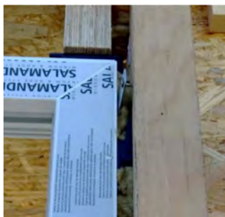
Abbildung 120 Verklotzen des neuen Fensters in der Konstruktion
