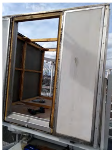
Abbildung 112 Teile der alten Eternitbeplankung
