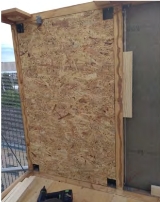
Abbildung 55 Montage OSB
