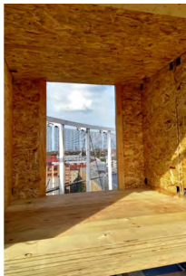
Abbildung 116 fertig beplankter Innenraum
