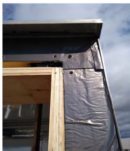
Abbildung 124 Bitumenabdichtung der Kubusflanken
