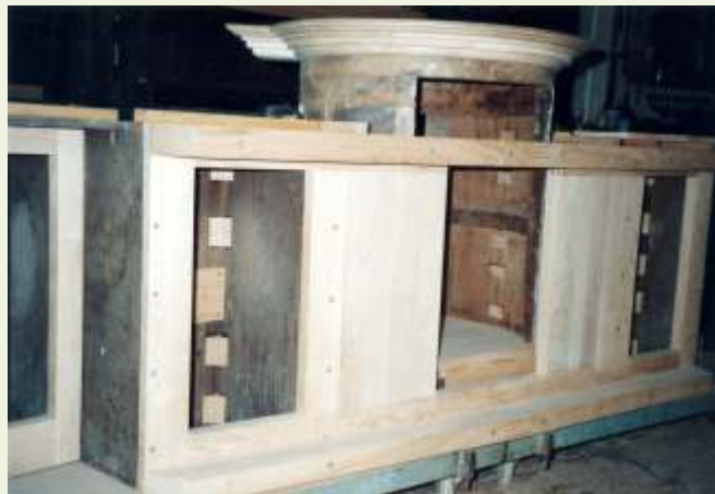
unten: Am stark beschädigten Oberteil waren einige Holzteile zu ersetzen.
