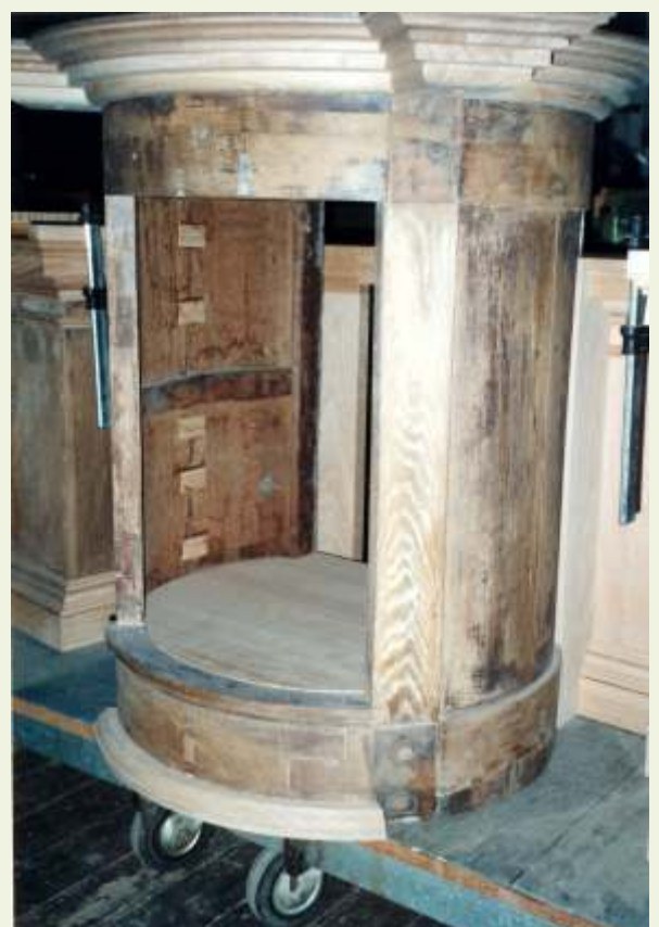
unten: Der Einsatz für das Tabernakel wurde verleimt und eine neue Abdeckung erstellt.
