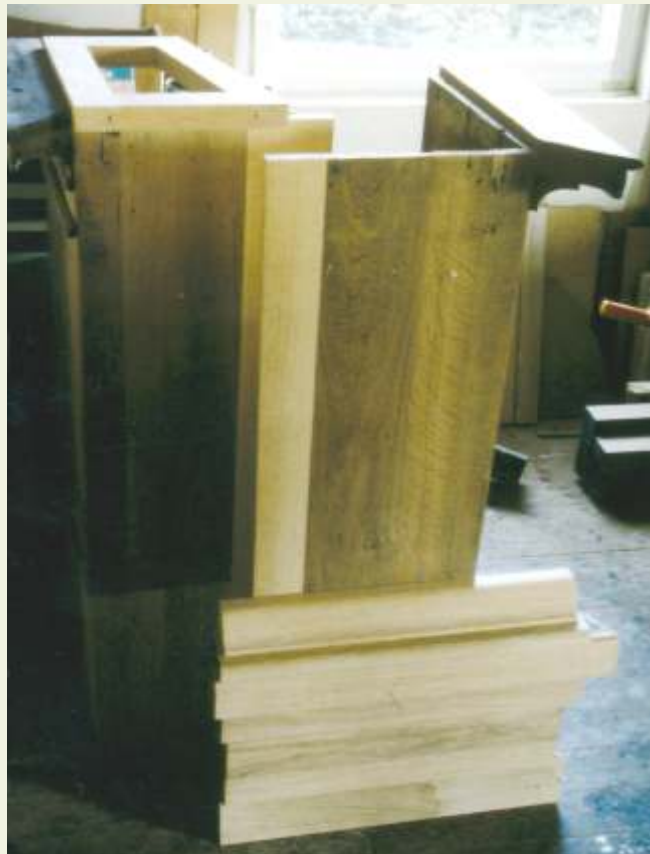
unten: Am stark beschädigten Oberteil waren einige Holzteile zu ersetzen.
