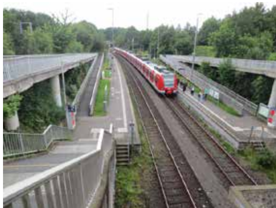
Mit dem S-Bahn-Halt in Köln Blumenberg ist der neue Stadtteil gut an das S-Bahn-Netz angeschlossen.
