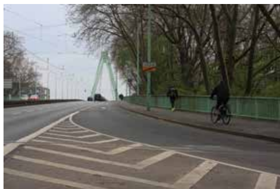
Zu schmaler Fuß- und Radweg an der linksrheinischen Auffahrt zur Severinsbrücke
