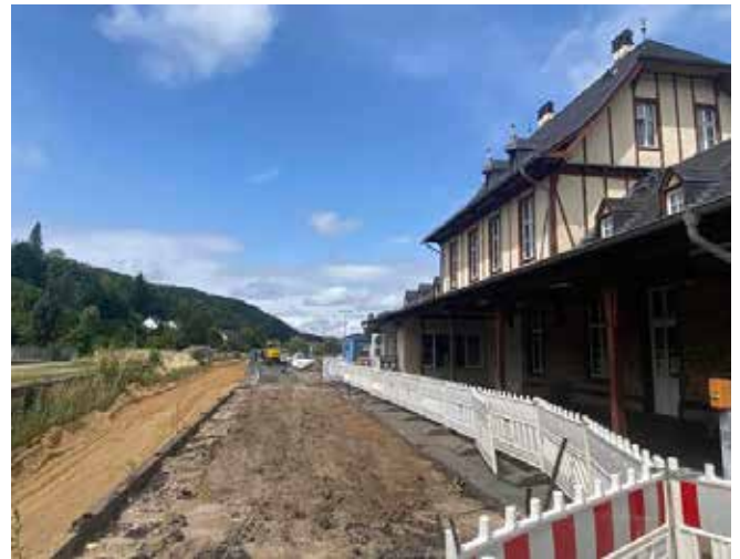
Wiederaufbau Bahnhof Bad Münstereifel
