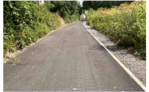
Sürther Leinpfad nach der Asphaltierung
