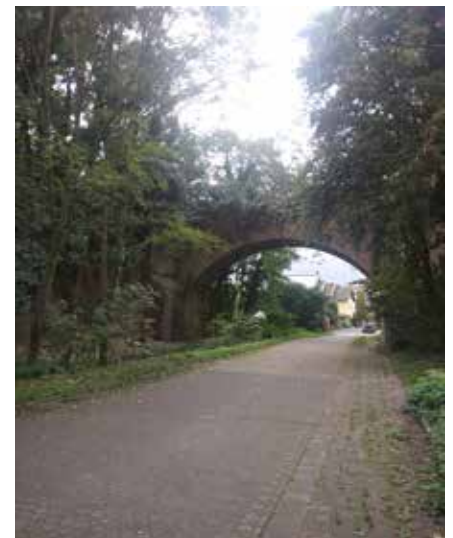
Brücke unmittelbar nach der Abzweigung in Horrem. Das Foto zeigt, dass die Fundamente für zwei Gleise ausgelegt wurden.
