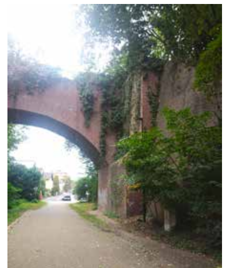
In weiten Teilen verläuft der Damm so hoch, dass die Anwohner bei einer Reaktivierung problemlos vor Lärm geschützt werden.
