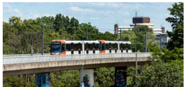
Hochtrasse der Linie 13 am nördlichen Gürtel Foto: Christoph Seelbach, Kölner Verkehrs-Betriebe AG
