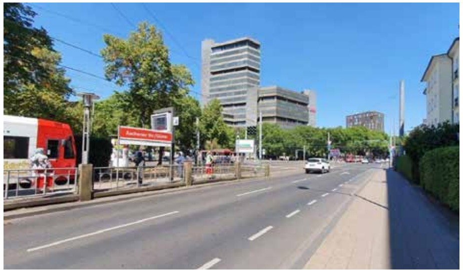
Stadtbahnhaltestelle Aachener Str./Gürtel
