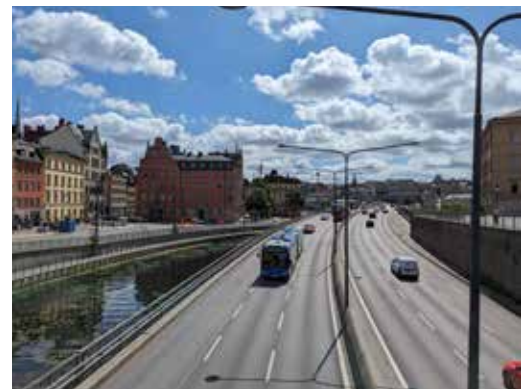
Stadtautobahn im Zentrum Stockholms
