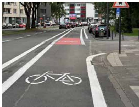
Wie hier am Blaubach gibt es an vielen Stellen der Stadt deutliche Verbesserungen bei der Radverkehrsinfrastruktur.
