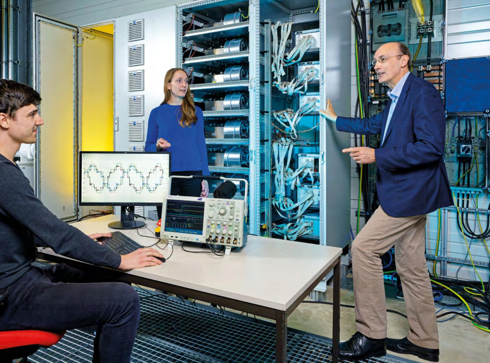
Bild 1: DC-DC-Leistungswandler, entwickelt am Institute for Power Generation and Storage Systems des E.ON Energy Research Centers, werden in Betrieb genommen. Sie erlauben flexible Betriebsstrategien für vielfältige Anwendungsfälle in DC-Netzen.
