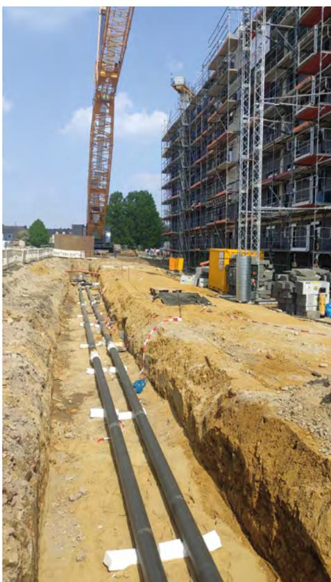
Bild 5: Verlegung von Rohrleitungen für ein kaltes Wärmenetz im Rahmen des Reallabors „TransUrban.NRW“
