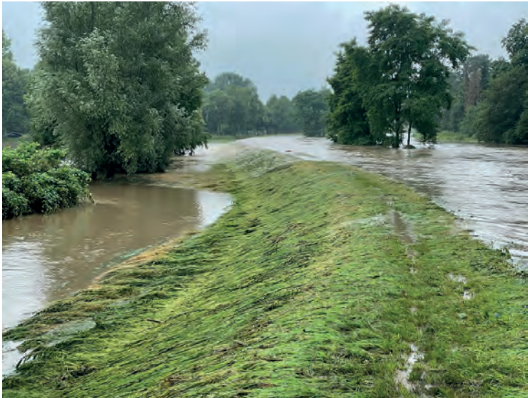
Bild 2: Hochwasser am Beginn der neuen Inde bei Lamersdorf. Links: Überströmen des Hochwasserdamms am 15.7.2021. Rechts: Situation am 23.7.2021. Fotos: Frank Lehmkuhl
