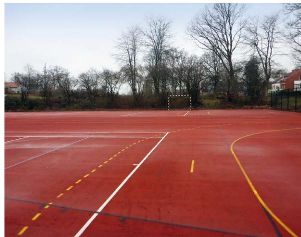
Abbildung 2.3: Kunststoffrasensystem und Kunststofffläche mit Markierungslinierung für mehrere Sportarten
