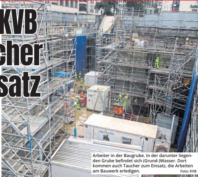
Arbeiter in der Baugrube. In der darunter liegenden Grube befindet sich (Grund-)Wasser. Dort kommen auch Taucher zum Einsatz, die Arbeiten am Bauwerk erledigen. Foto: KVB
