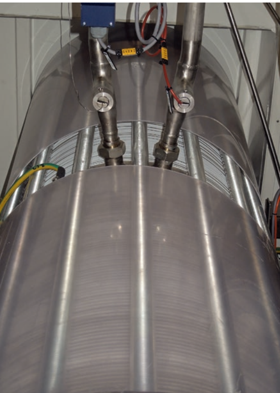
Abb. 3: Elektrolysestack der Firma Hydrogenics zur Wasserstoffherzeugung
