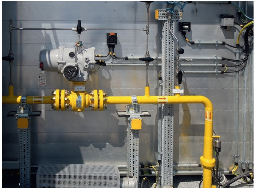
Abb. 2: Automatisierter Kugelhahn zur Trennung einer Wasserstoffleitung von einer Erdgasleitung in einer Wasserstoffeinspeiseanlage; der Kugelhahn ist Teil einer PLT-Sicherheitseinrichtung (PLT: Prozessleittechnik).
