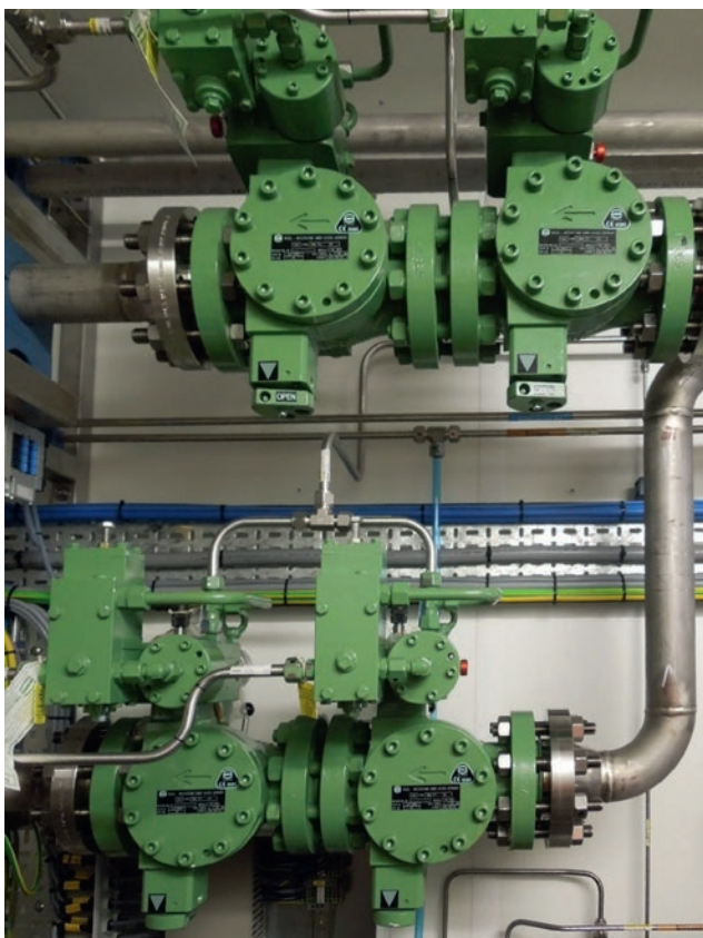
Abb. 1: Sicherheitsabsperrentile in einer Wasserstoffherzeugungsanlage
