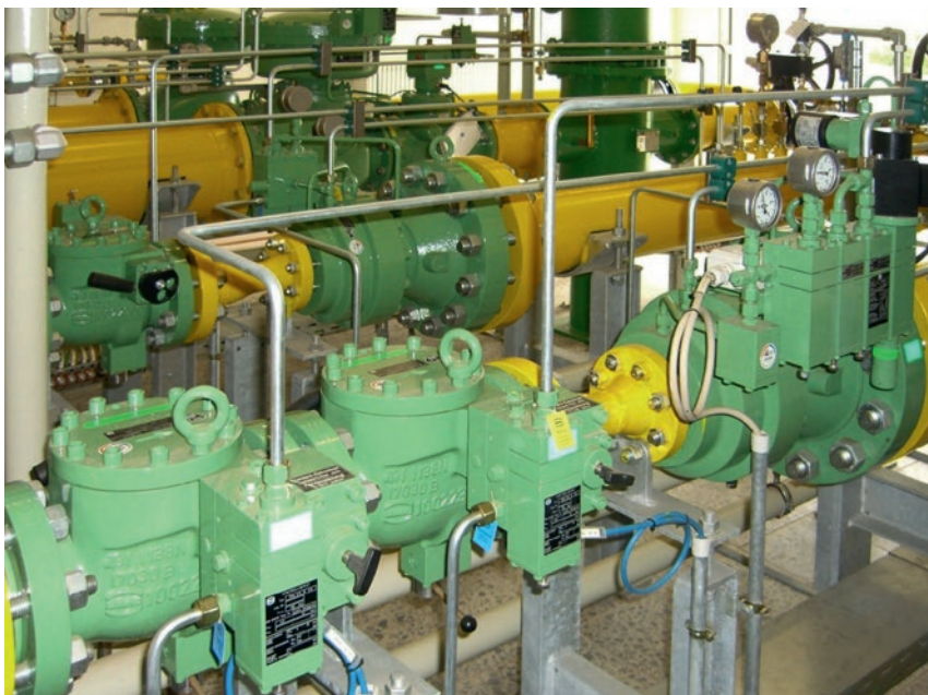
Abb. 3: Erdgas-Regelstrecke auf einem Werksgelände zur Versorgung einer Thermoprozessanlage
