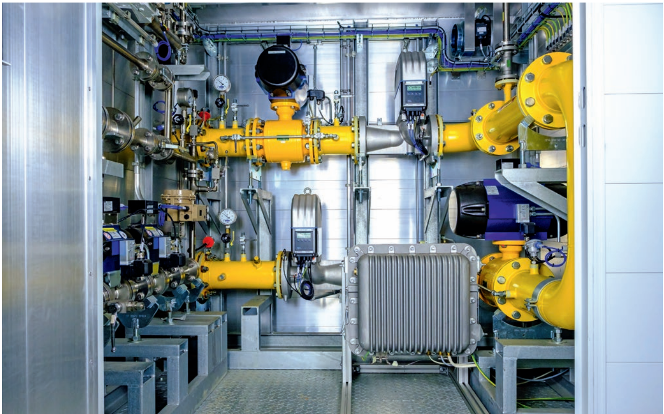
Abb. 3: Messgerät des Fraunhofer IPM (Gehäuse mit Kühlrippen im unteren Bildteil), installiert am Erdgas-Bypass des Fraunhofer ISE. Das Messgerät ist in einem explosionsgeschützten Koffergehäuse platziert, alle elektrischen Leitungen werden aus dem Bypass-Container herausgeführt.
