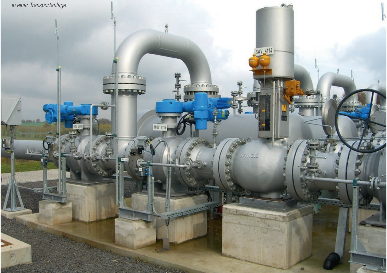
Abb. 4: Sicherheitsabsperrenteil in einer Transportanlage
