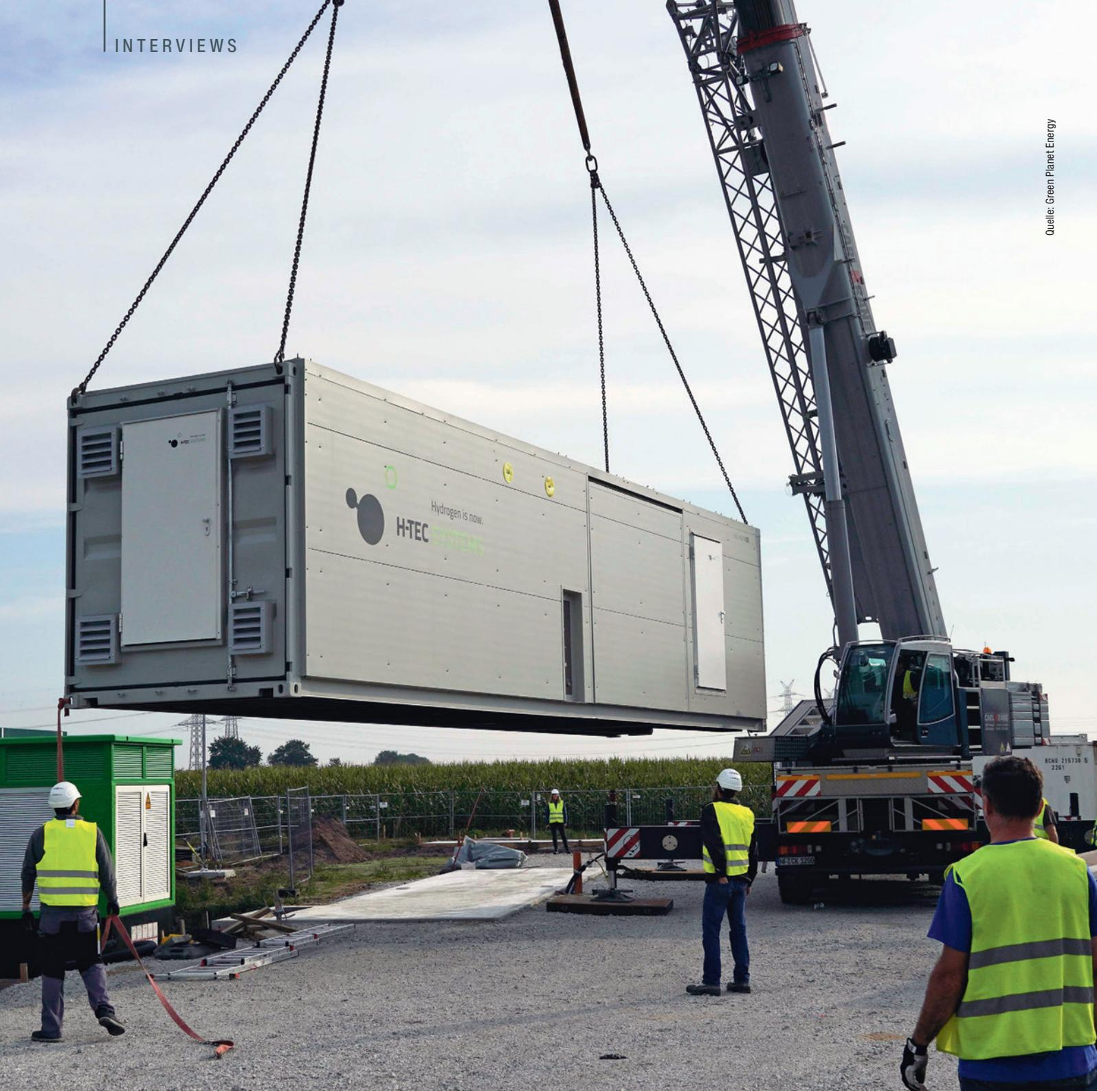
Der Elektrolyseur vom Typ ME 450/1400 des Herstellers H-TEC SYSTEMS wird von Energie des Nordens und Green Planet Energy gemeinsam betrieben.
