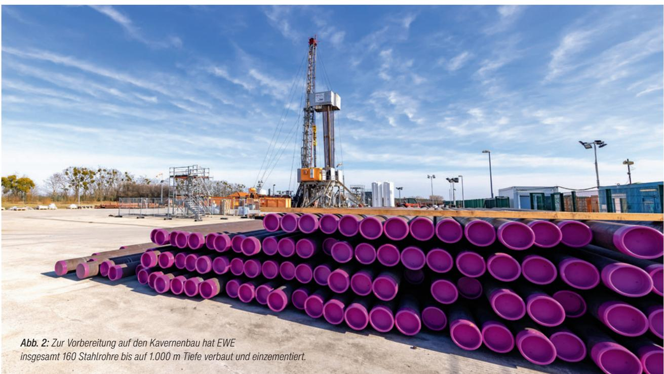
Abb. 2: Zur Vorbereitung auf den Kavernenbau hat EWE insgesamt 160 Stahlrohre bis auf 1.000 m Tiefe verbaut und einzementiert.
