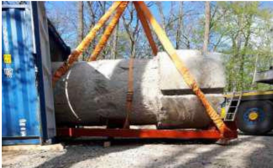
**Abb. 6.2** Bergung der „Well type“-Lager für ausgediente Strahlungsquellen in Tsebuleve /SNR 20/
