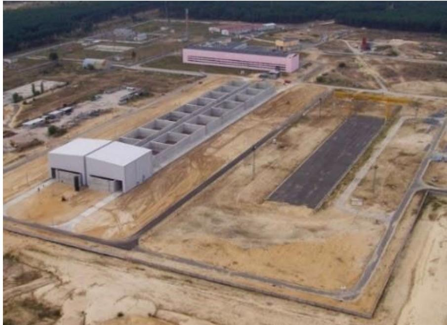
**Abb. 6.3** Oberflächennahes Endlager (ENSDF) in der Sperrzone von Tschernobyl mit zwei parallelen Abschnitten aus je 11 Stahlbetonmodulen /SNR 20/
