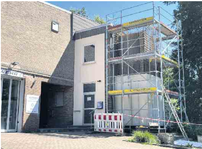
Baustelle am Haus des Dorfes Niedermerz. Foto: Gemeinde Aldenhoven
