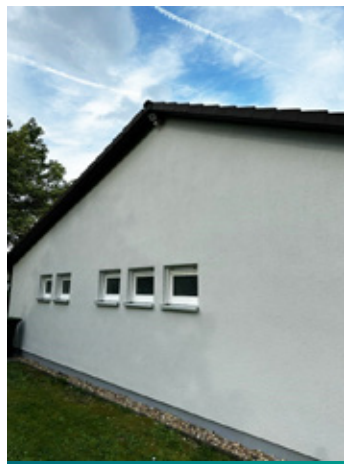
Die Fassade des Clubhauses des Morsbacher Tennisvereins vor und nach der Sanierung. Foto: Tennisabteilung SV Morsbach
