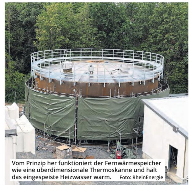
Vom Prinzip her funktioniert der Fernwärmespeicher wie eine überdimensionale Thermoskanne und hält das eingespeiste Heizwasser warm. Foto: RheinEnergie
