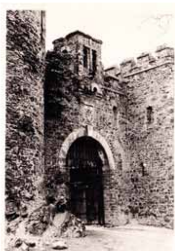
Eingang vor der Restaurierung
