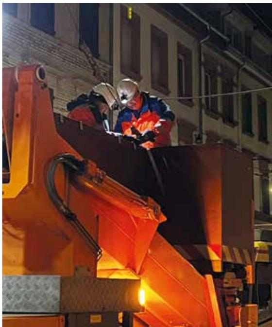
Oberleitungsmonteure der VBK Karlsruhe im nächtlichen Einsatz bei der Reparatur einer defekten Seilschleife auf einem Turmwagen
