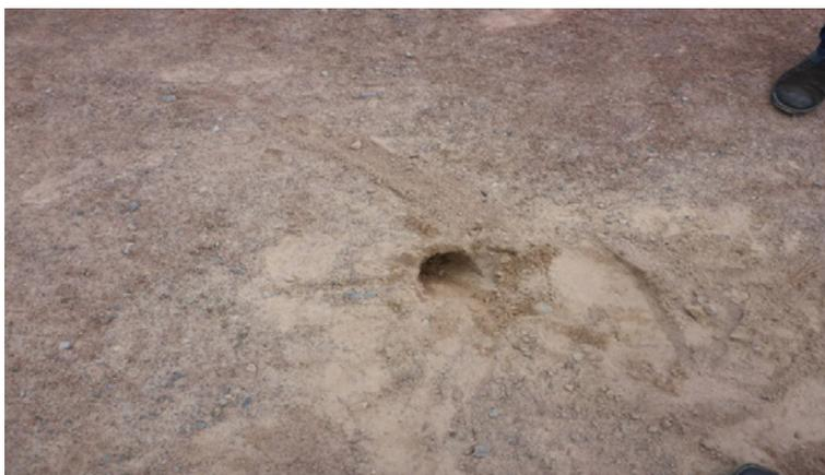
*Löcher im Tennenbelag und Grobkorn auf der Deckschicht*
