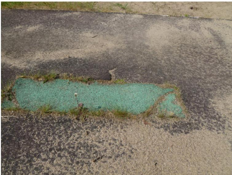
*Defekter Belag und Absprungbalken an der Sprunggrube können zu Stolpern und Stürzen von Nutzenden führen.*
