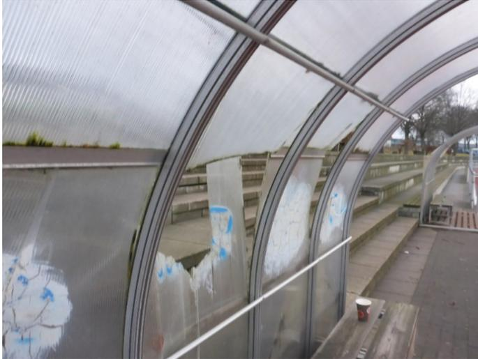
*Defekte Wände eines Unterstands haben in der Regel scharfe Kante, an denen sich der Nutzer verletzen kann.*
