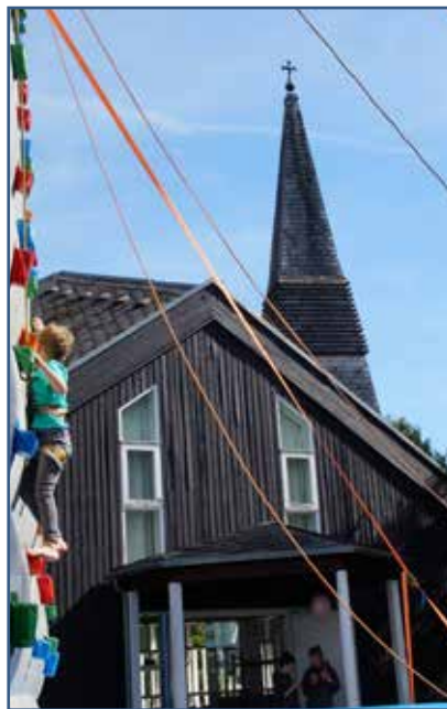
Holzfassade der Friedenskirche
