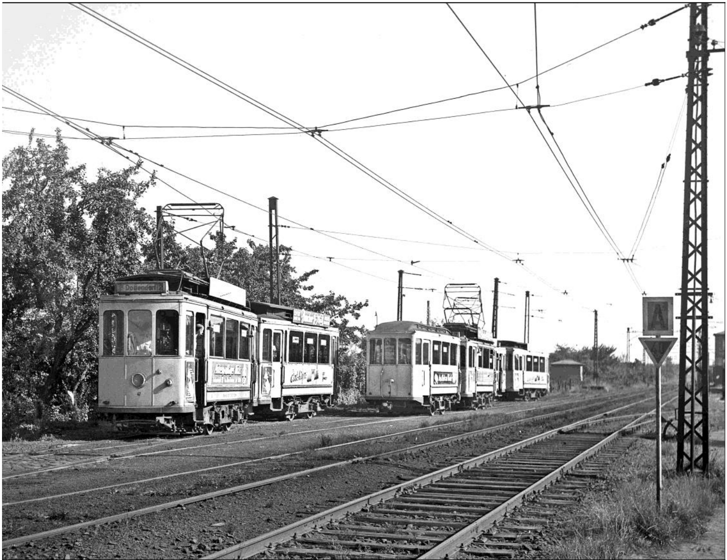
Mit drei Zügen der Linie 2 war am 1. September 1958 die von 1911 bis 1958 betriebene Abstellanlage voll ausgelastet. Der Triebwagen im rechten Gleis musste seinen Beiwagen noch umfahren. Vorn stand ein ausfahrbereiter Zug mit Wagen 47 (Baujahr 1914, Herbrand), der eine Rollbandanzeige erhalten hatte. ■ Foto : Karl-Heinz Wipperfürth, Sammlung Axel Reuther
