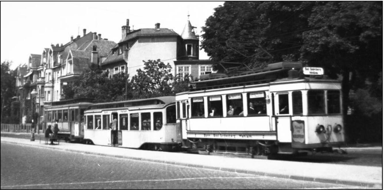
Ein BGM-Zug hielt am 1. Juni 1950 an der Haltestelle Reuterstraße. Bis zum Neubau der Reuterbrücke 1962 lag die Trasse in Seitenlage. Hinter dem Triebwagen 2 war der niederflurige Beiwagen 47 gereiht, der ein bequemes Einsteigen ermöglichte.
