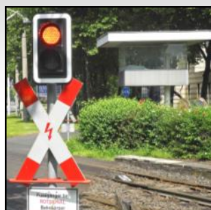
■ Geschichte: Das Stellwerk „Abzweig B 9“
