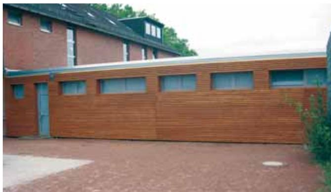
Die energetische Sanierung an der Aussen – WC – Anlage ist nunmehr komplett fertig gestellt worden. Zuletzt wurde, wie auf dem Foto zu erkennen ist, die rückwärtige Aussenwand am Mini-Spielfeld mit einer Holz-Leisten-Deckung in Douglasie und dahinter liegender Wärmedämmung verkleidet.
