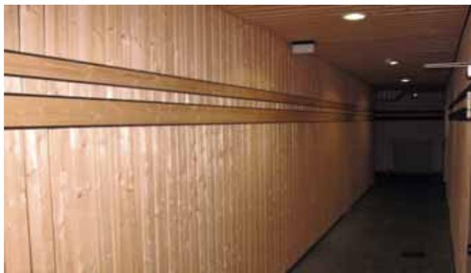
In den Umkleideräumen und Fluren des Schwimmbades wurden entsprechende Verkleidungen mit dahinter liegender Akustikdämmung an die Wände und Decken angebracht. Die Beleuchtung wurde in die Decke integriert und mit Bewegungsmeldern versehen, so dass eine unnötige Energieverschwendung durch eine nicht ausgeschaltete Beleuchtung nunmehr der Vergangenheit angehört.
