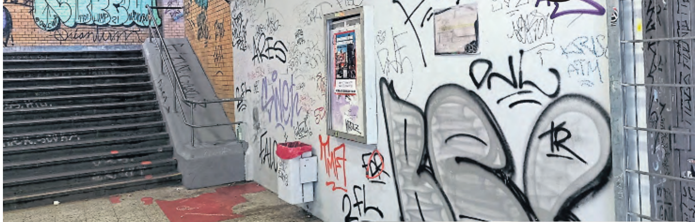
Das sieht nicht gerade einladend aus. Ein Blick in den Bahnhof Köln West. Foto: NVR
