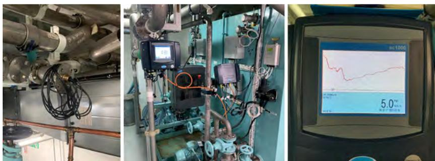
Abb. 3: An Bord installierte Messtechnik zur Überwachung der biologischen Prozesse in der Schiffskläranlage - links: Sondeneinbau in Rohrleitung mit in OSCAR entwickeltem Adapter, Mitte: OSCAR-Monitor direkt an der Anlage, rechts: Live-Messwertanzeige
