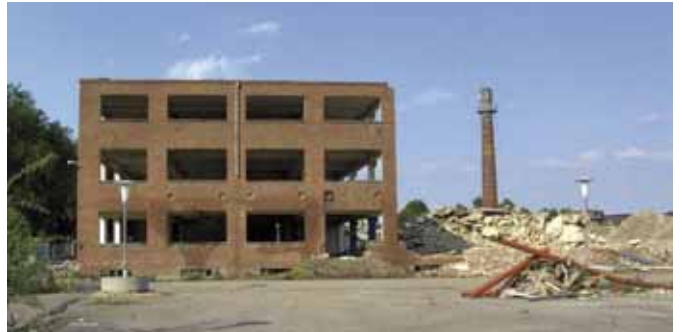
Kreuzau-Friedenau, Abbruch Werk II, Firma Hoesch
