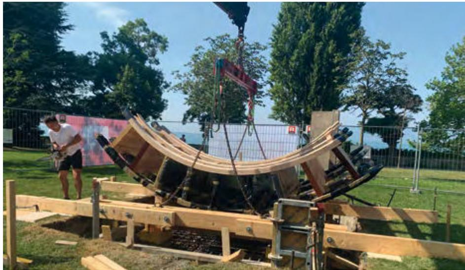
**Bild 17:** Das erste Element ist termingenau mit einem Hilfsgerüst versetzt. Am folgenden Tag wird das Fundament mit Beton gegossen.
