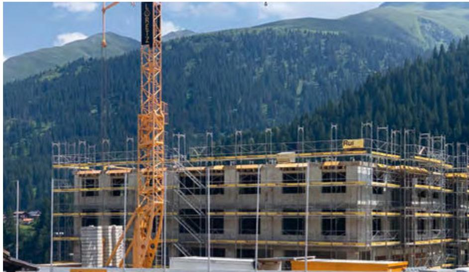
**Bild 2: Betonrohbau für Alterswohnungen mitten in einem Graubündner Bergdorf, wo rundherum alles in Holz gebaut ist**
