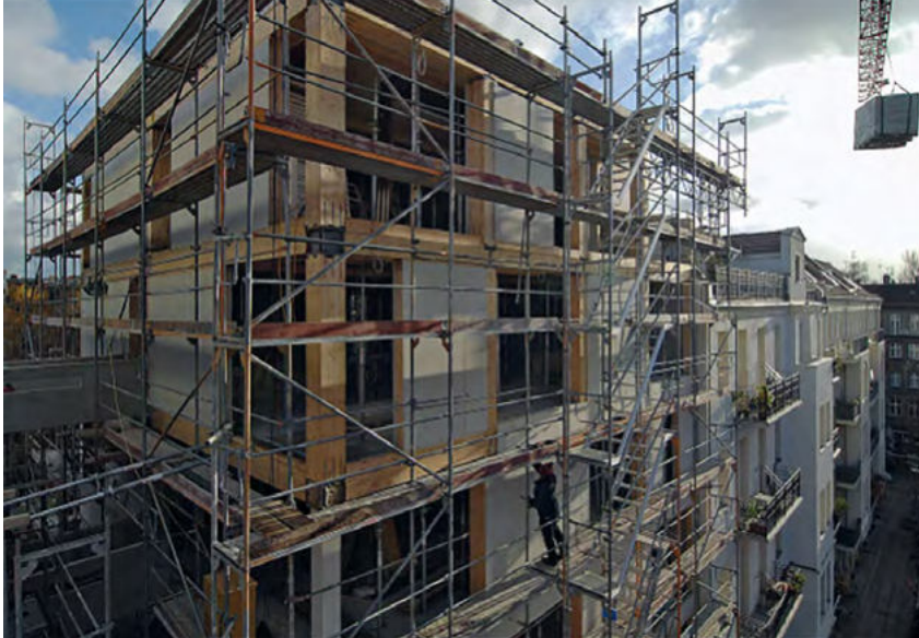
Bild 3: e3 in Berlin, eine Pfosten-Riegel- Konstruktion
