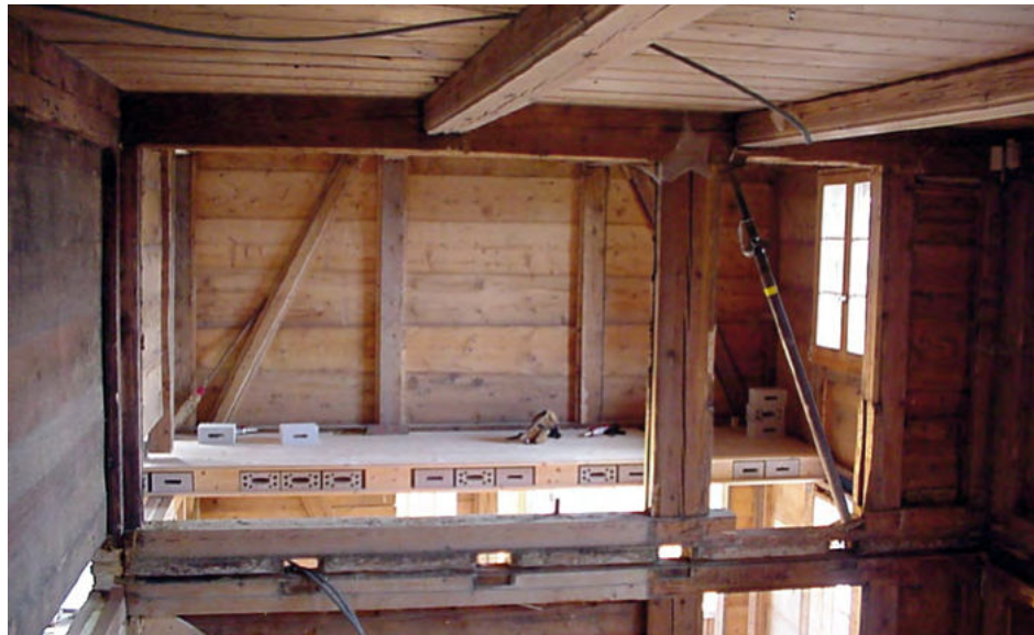
Bild 6: Lignatur silence Decke mit einer Tieftön-Schalldämmung
