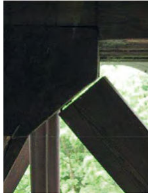
(c) Anschluss der Diagonale
