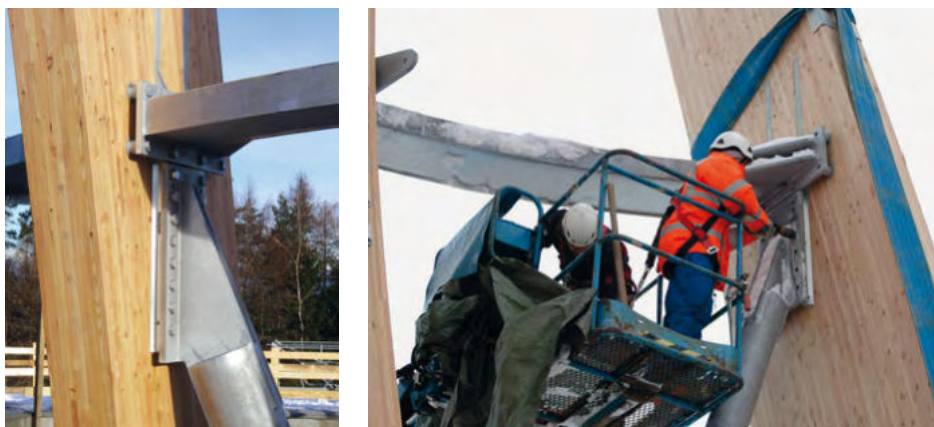
Bild 5: Anschluss von Stahlteilen an einem aufsteigenden Holm des Pyramidenkogels
