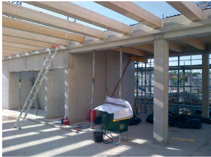
Bild 3 (unten): Positionierung der Verbundmittel für die HBV-Decke
