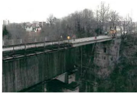
Bild 3: Gesprengtes östliches Feld, ab Mai 1945 als Stahl-Beton-Verbundbrücke wiederhergestellt (siehe [5])
