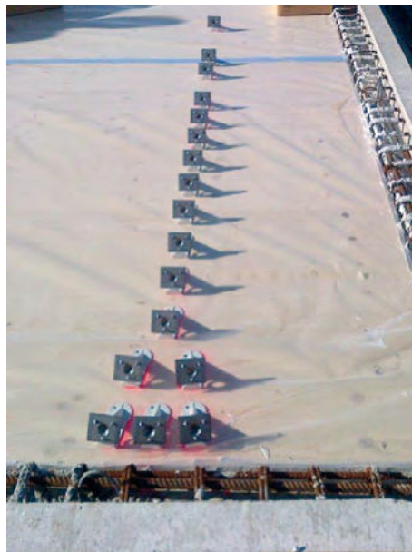
Bild 3 (unten): Positionierung der Verbundmittel für die HBV-Decke
