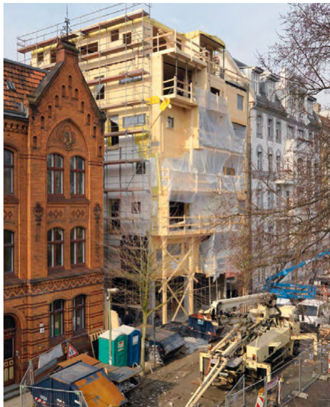
Bild 6: c13 in Berlin, der Rohbau der siebengeschossigen Massivholzkonstruktion
