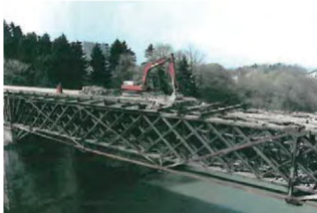
(a) Abräumen der Fahrbahn
