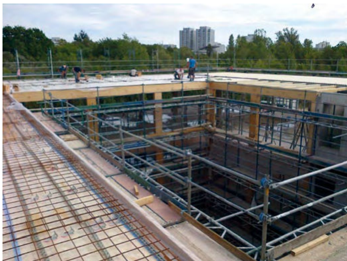
Bild 1: Montage Holzkonstruktion und HBV-Decken im Innenhofbereich
