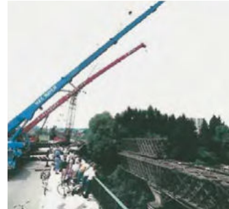
(b) Ausheben der Träger
