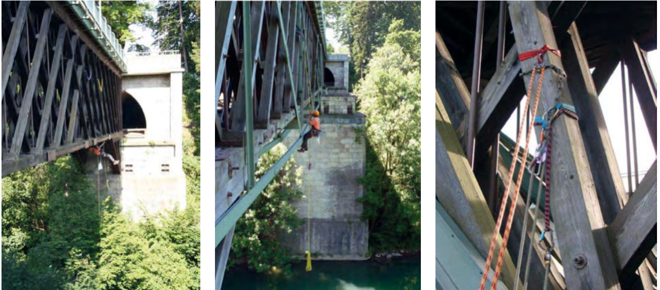
Bild 6: Bauwerksprüfung durch Klettertechnik
