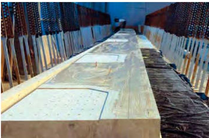
**Bild 11: Schlitzblechfräsungen in der Klebefuge**
