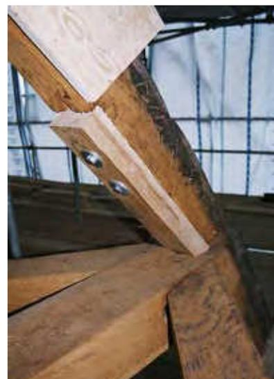
**Bild 3 (rechts):** Sanierungspunkt - Knagge in neuem Versatz
