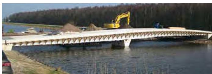
Bild 7: Montage eines Holzträgers für eine Holz-Beton-Verbundbrücke
