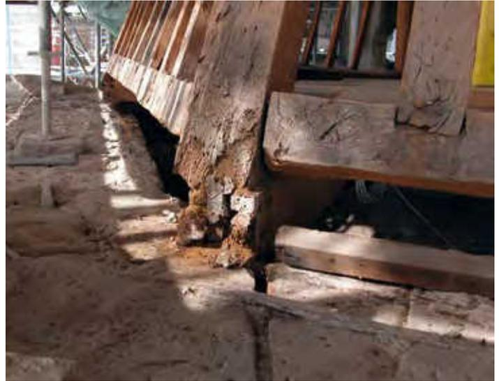
**Bild 9 (rechts):** stark zerstörter Balkenkopf
