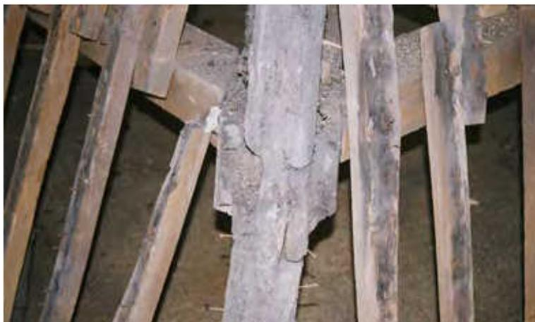
**Bild 2 (links):** nach Demontage der Schalung - Sparren nur aufgenagelt, teilweise gebrochen
