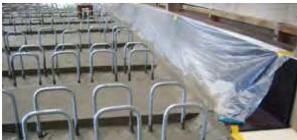
Bild 4: Schubverbinder: Kerven, Kopfbolzen und Streckbleche
