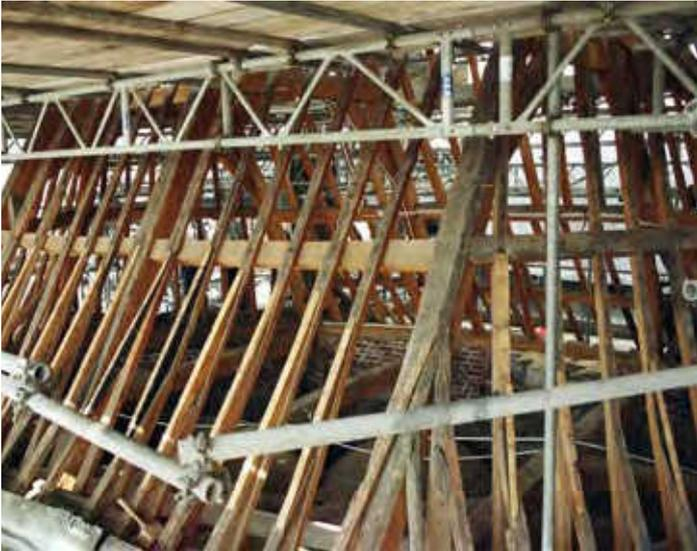
**Bild 8 (links):** Dachstuhl nach der Demontage von Schiefer und Schalung
