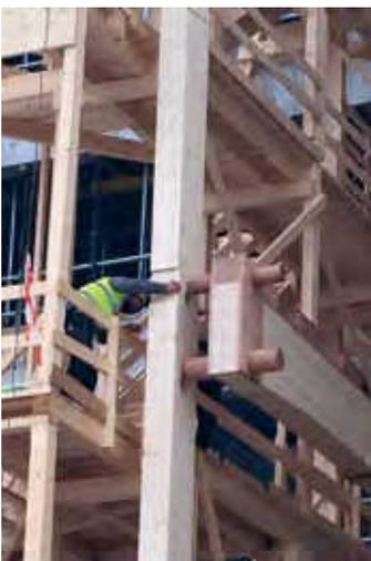
**Bild 7:** Biegesteifer Anschluss Zangen-
