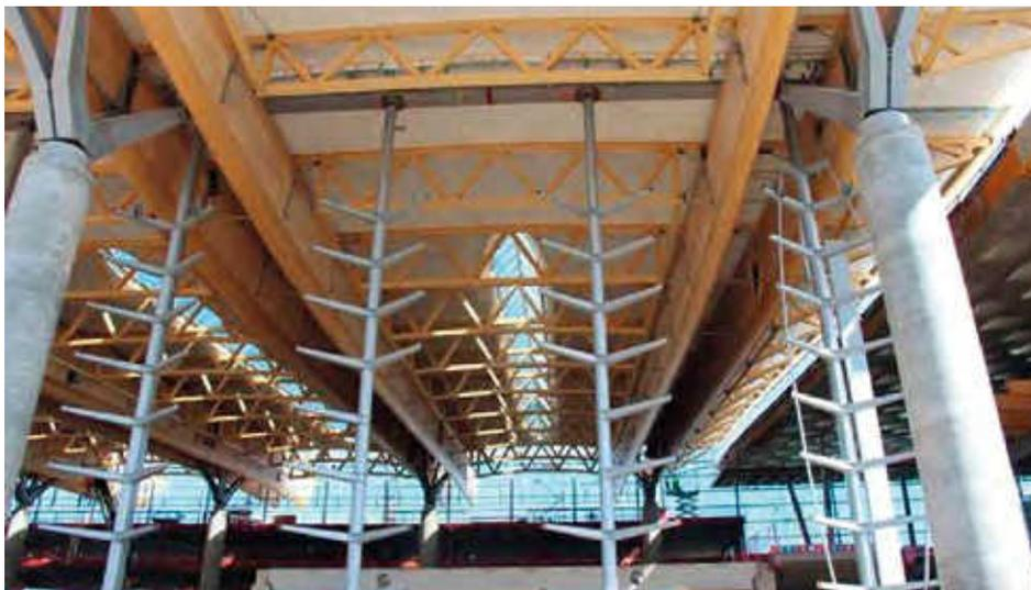
**Bild 7: Ansicht Sekundär- Fachwerkträger**
