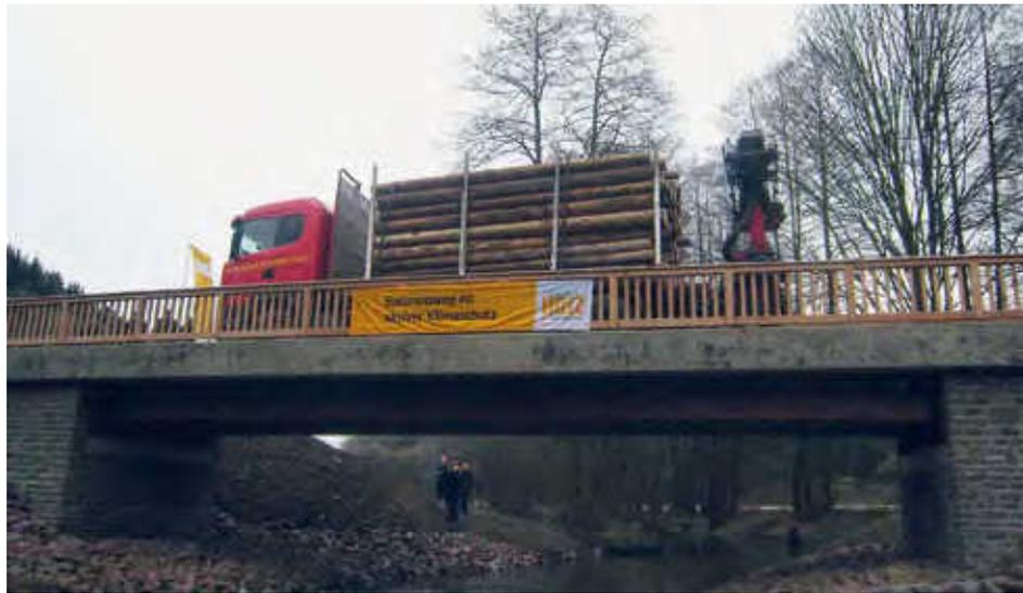
**Bild 2: Birkbergbrücke – erste HBV Brücke in Deutschland (Entwurf Büro Setzpfand)**
