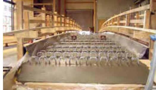
**Bild 11: Integrale Holz-Beton-Verbundbrücken Schwäbisch Gmünd (Entwurf Büro Graf)**
