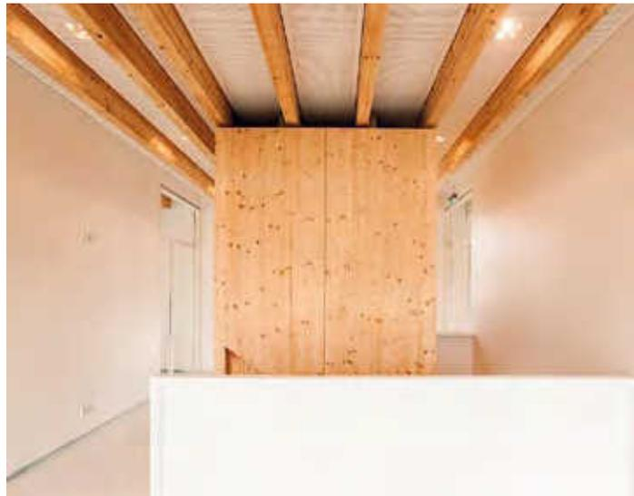
**Bild 12 (links):** Treppenraum mit zentralem Fahrstuhlschacht aus Brettschichtholzelementen.
