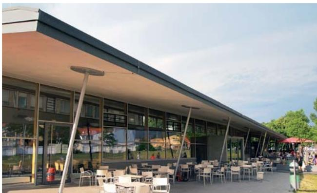
**Bild 1:** Punktgestütztes Dachtragwerk, Mensa der Universität Bamberg
