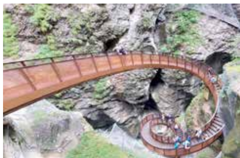
Spiraltreppe in der Lichtensteinklamm
