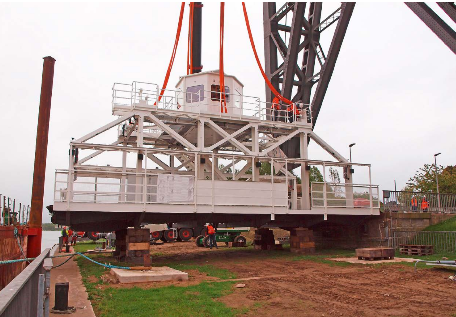
Abladen der Fahrstufe am Ufer des NOK
