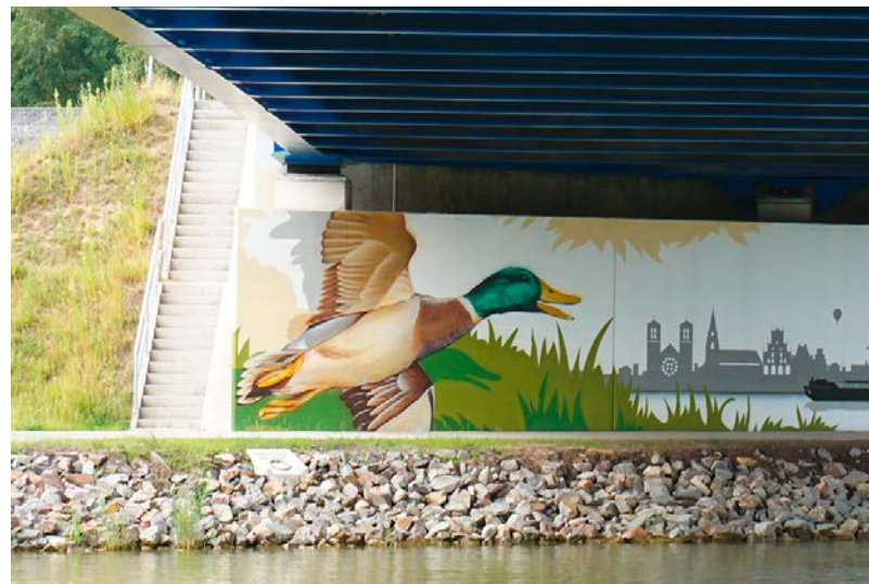
Blick auf die gesprayte Silhouette der Stadt Münster und ein vorbeifahrendes Binnenschiff auf dem nördlichen Widerlager
