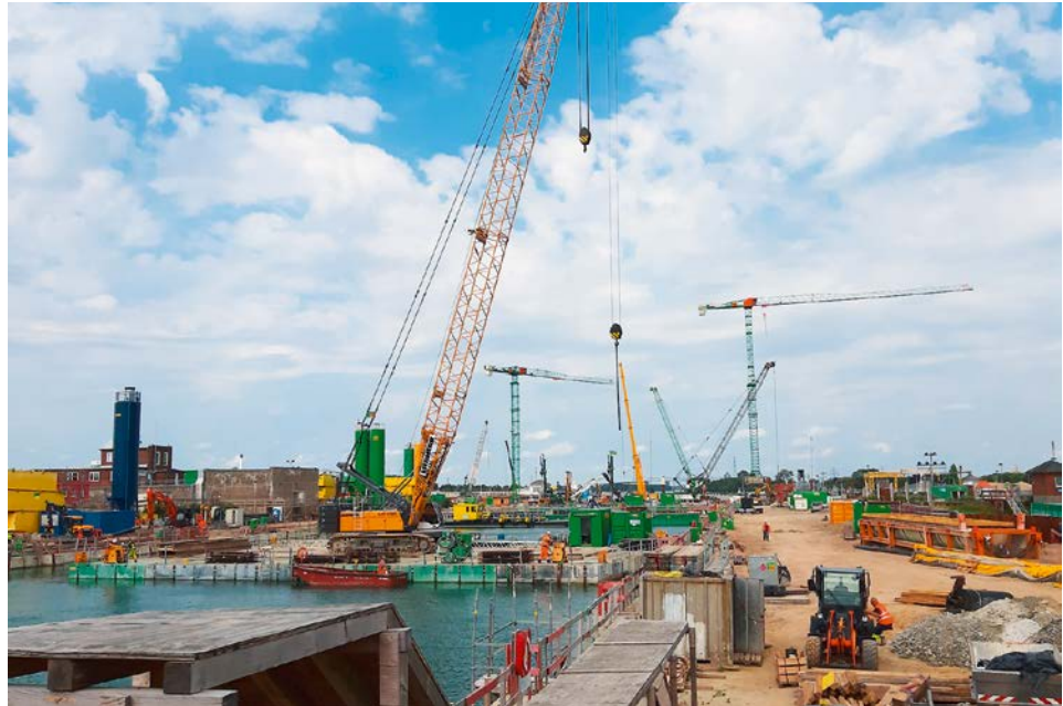
Baustelle 5. Schleusenammer Brunsbüttel im Vollbetrieb: Dialogverfahren und daraus entwickelte Einigung bringen die Baustelle unverkennbar voran
