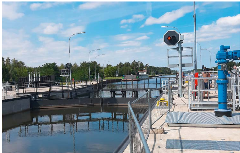
Die neue Südkammer der Schleuse Wusterwitz ist eröffnet: Sachlichkeit und Vertrauen haben die Baupartner wieder zusammengeführt
