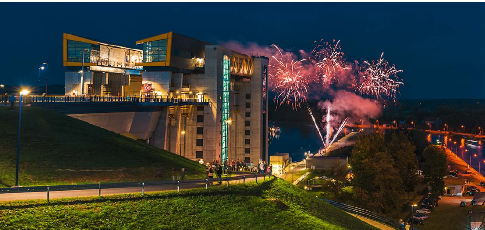
Feuerwerk zur Inbetriebnahme des neuen Schiffshebewerks
