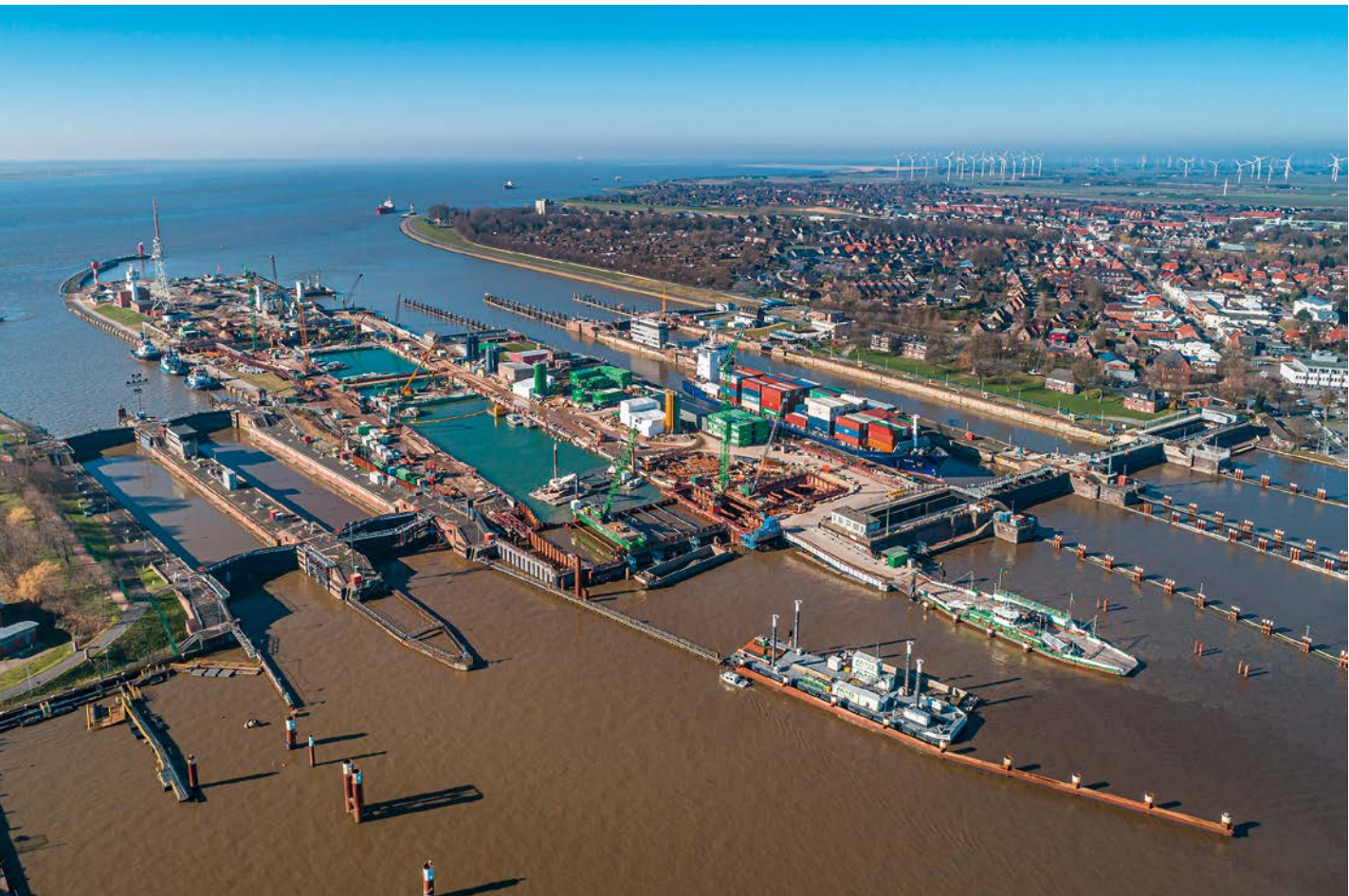
Blick über die NOK-Schleusen Brunsbüttel mit der im Bau befindlichen 5. Kammer
