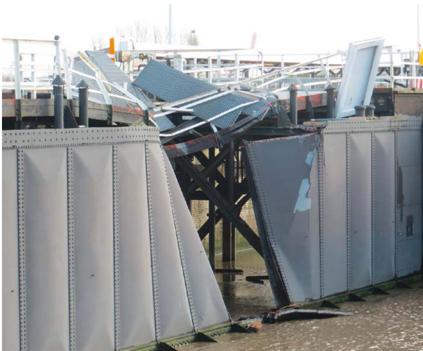
Zerstörtes Schleusentor in Brunsbüttel nach einer Havarie im Januar 2015
