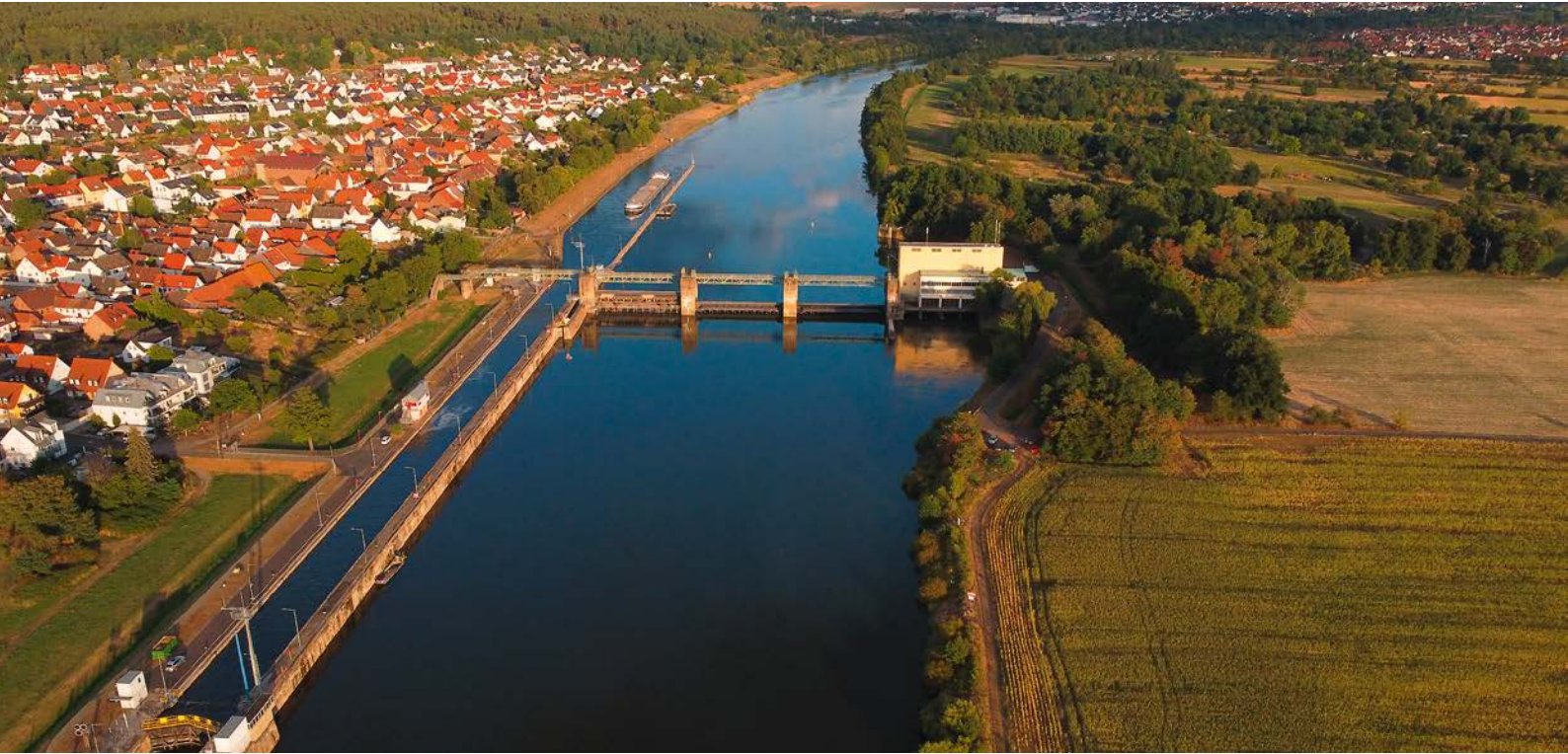
Luftbild der Staustufe Obernau
