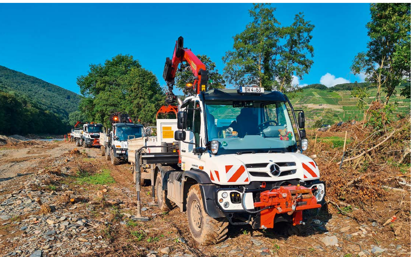
Aufräumarbeiten durch die WSV im August 2021
