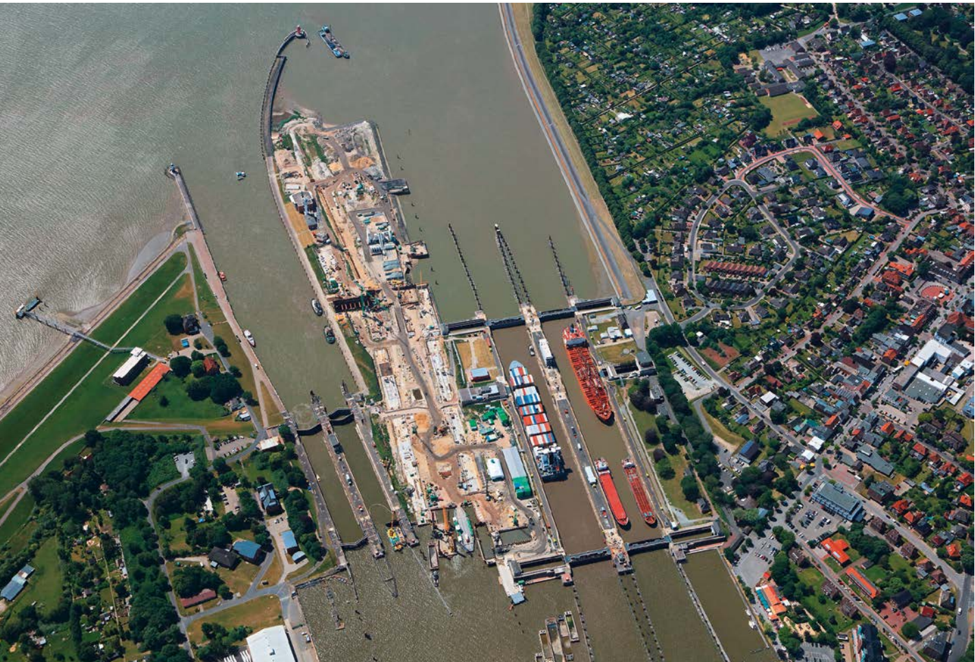
Die Schleusenanlage in Brunsbüttel
