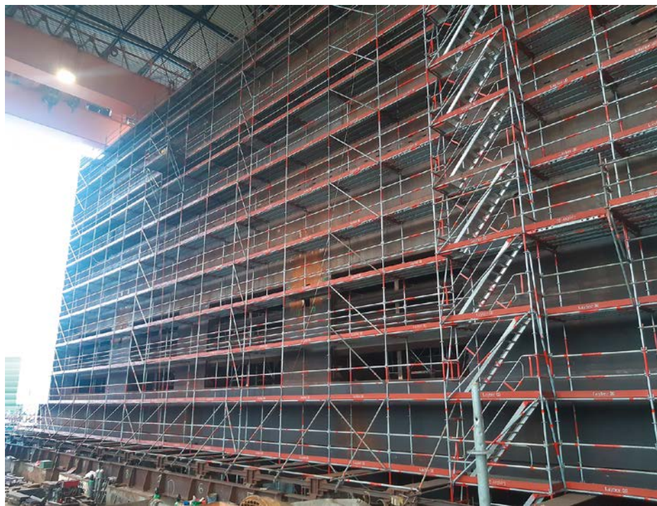
Eines der drei neuen Schleusentore in der Emdener Werfthalle
