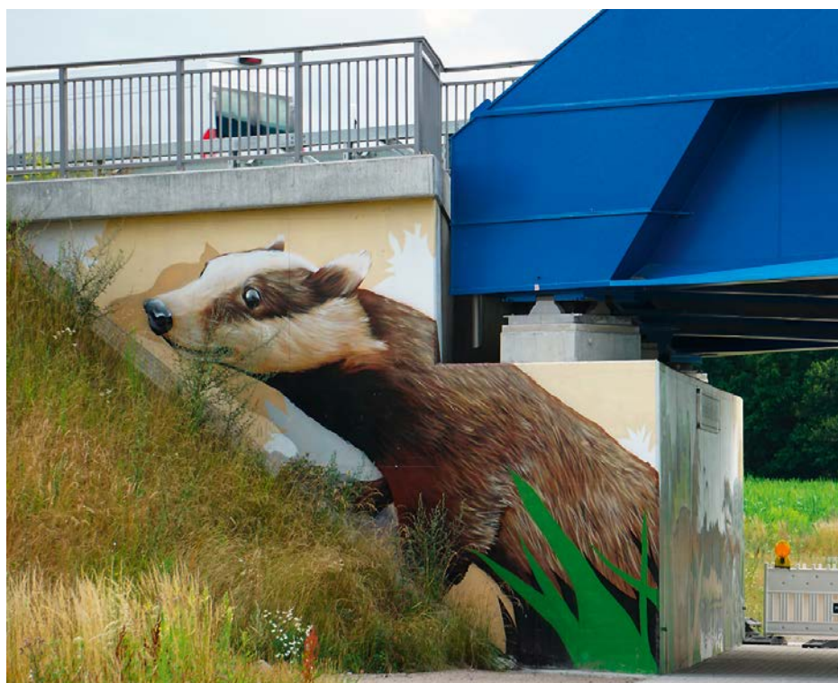
Blick auf den Dachs, der auf eine Flügelseite des südlichen Widerlagers gesprayed wurde
