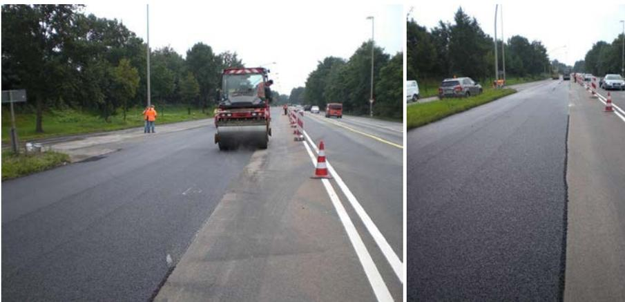
**Abbildung 4-62:** Einbau des Übergangsbereiches SMA 8 Hmb. mit dem Rejuvenator R1 und R8.
