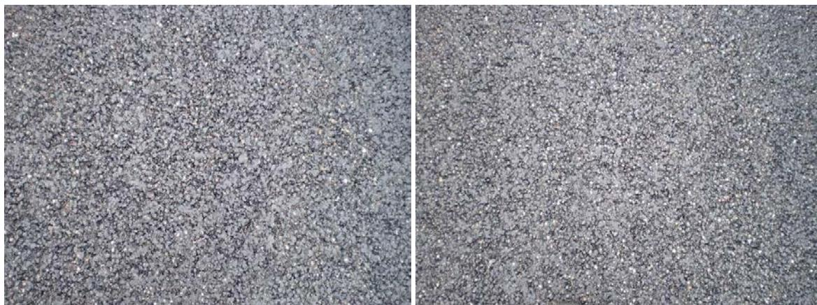
**Abbildung 4-59:** Oberfläche des Übergangsbereiches SMA 8 Hmb. Nullvariante zu SMA 8 Hmb. mit R1 nach der abgeschlossenen Walzverdichtung.
