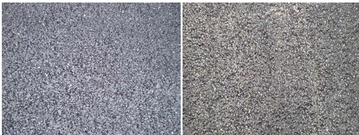
**Abbildung 4-58:** Oberfläche des SMA 8 Hmb. als Nullvariante nach der abgeschlossenen Walzverdichtung.
