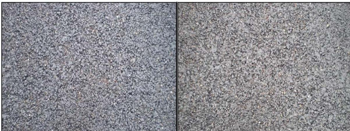
**Abbildung 4-63:** Oberfläche des SMA 8 S Hmb. mit R1 nach der abgeschlossenen Walzverdichtung und Abstreuerung.
