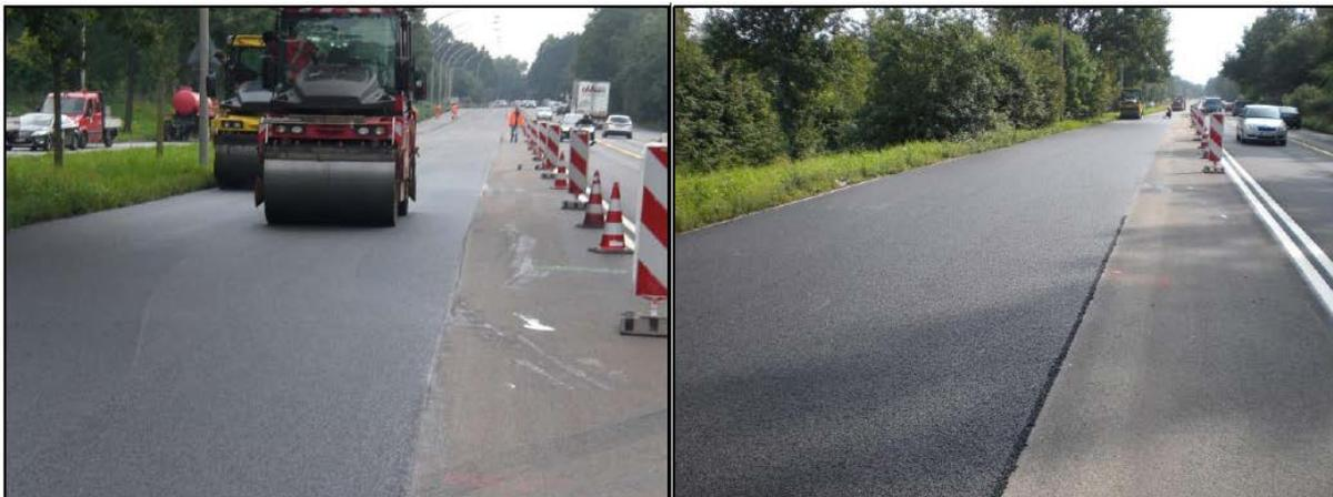
Abbildung 4-66: Einbau des SMA 8 Hmb. mit R8.
