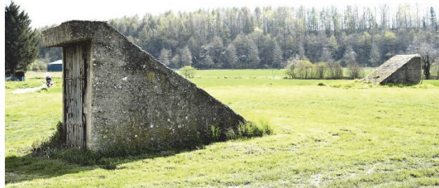
Bild 6: Luftschutzbunker in Frimmersdorf an der Kauler Hüll
