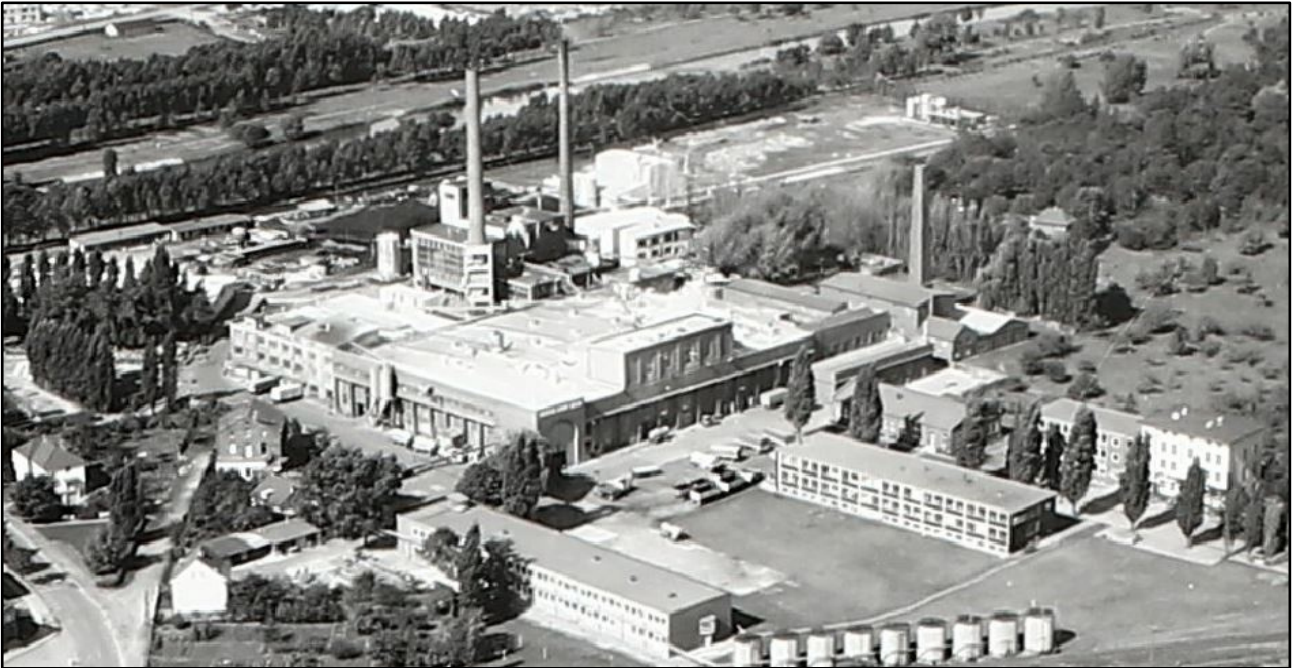
Abbildung 14: Chemische Fabrik Düren-Krauthausen, Kreuzauer Straße, Schrägluftbild ca. 1962 (Quelle: StuKrADN)
