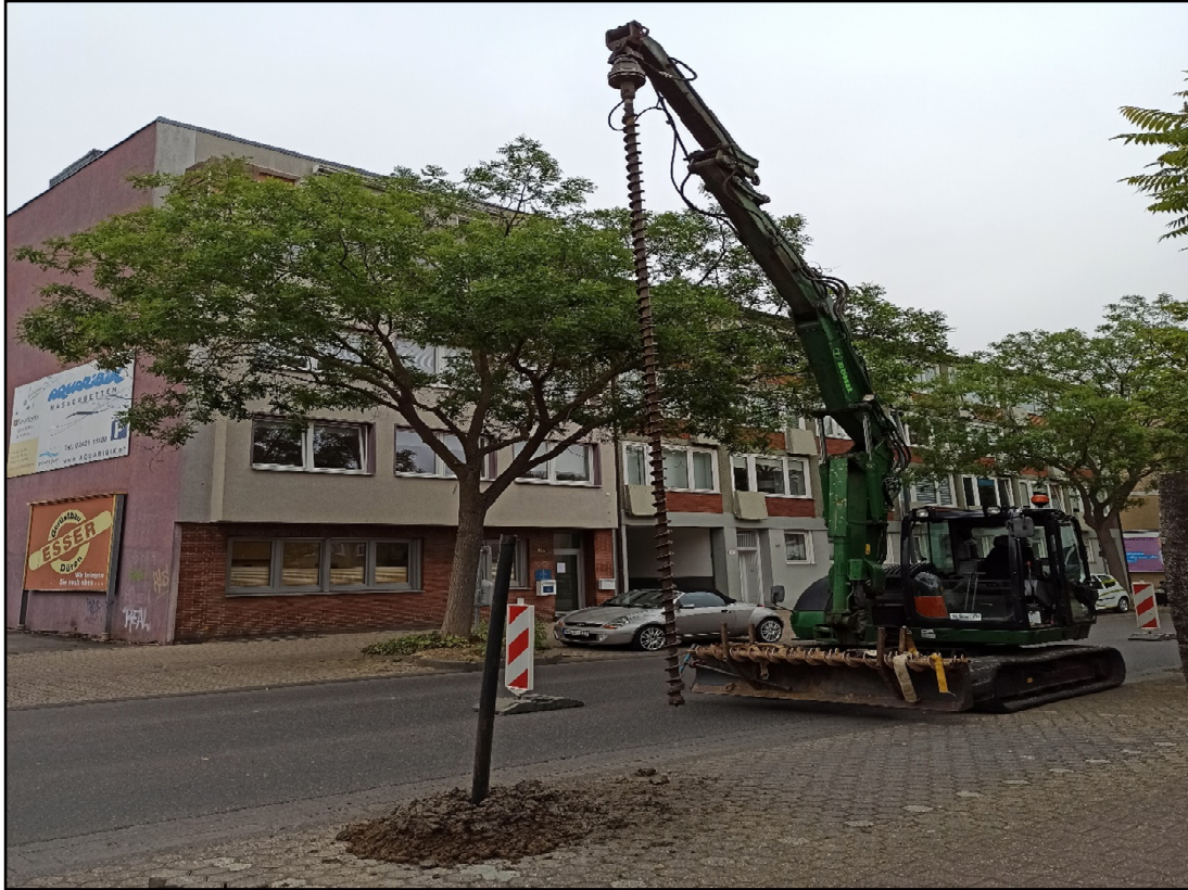
Abbildung 5: Frontansicht des Standortes der ehemaligen chemischen Reinigung Oberstraße zum Zeitpunkt der Sondierungsarbeiten zum Bau der Grundwassermessstellen.
