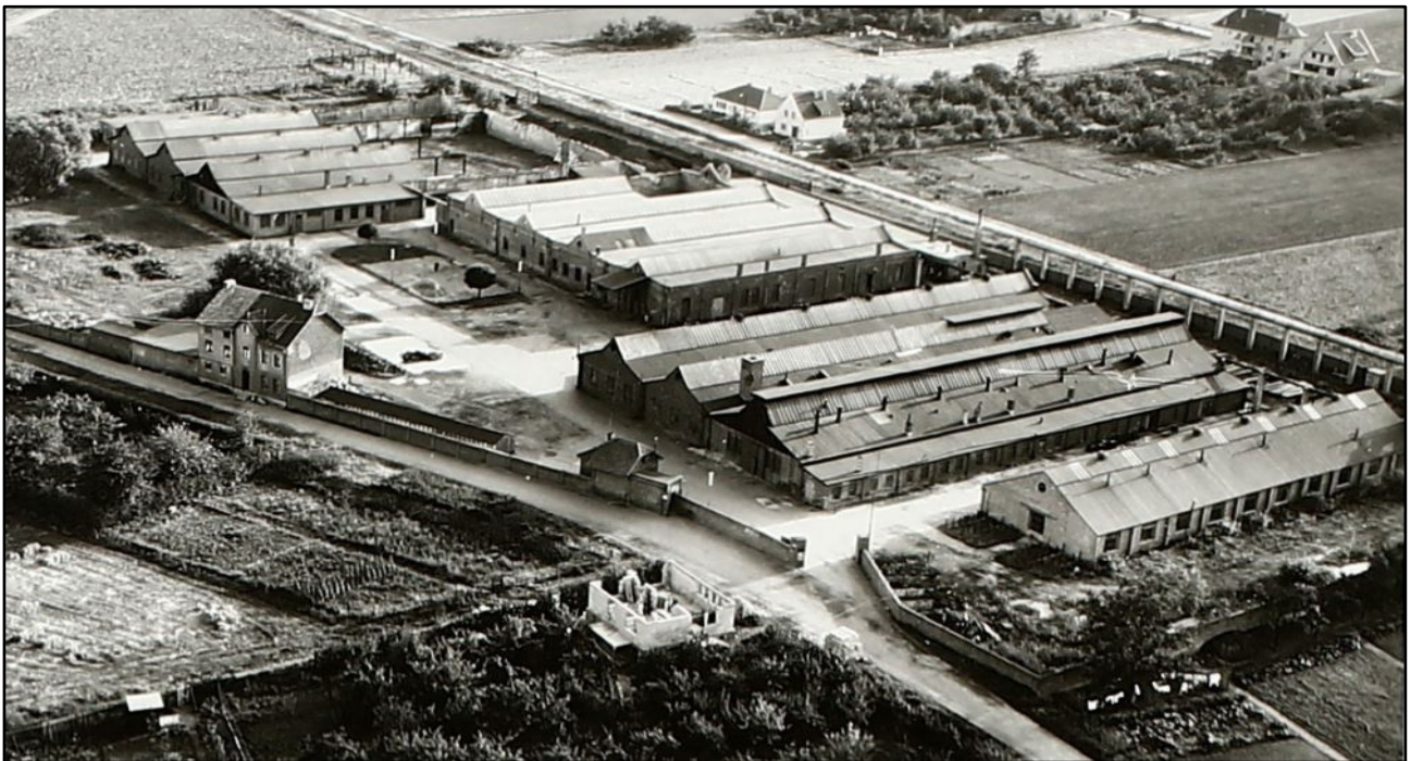
Abbildung 8: Ehem. Apparatebau Düren-Gürzenich, Buschstraße, Schrägluftbild 1957 (Quelle: StuKrADN)
