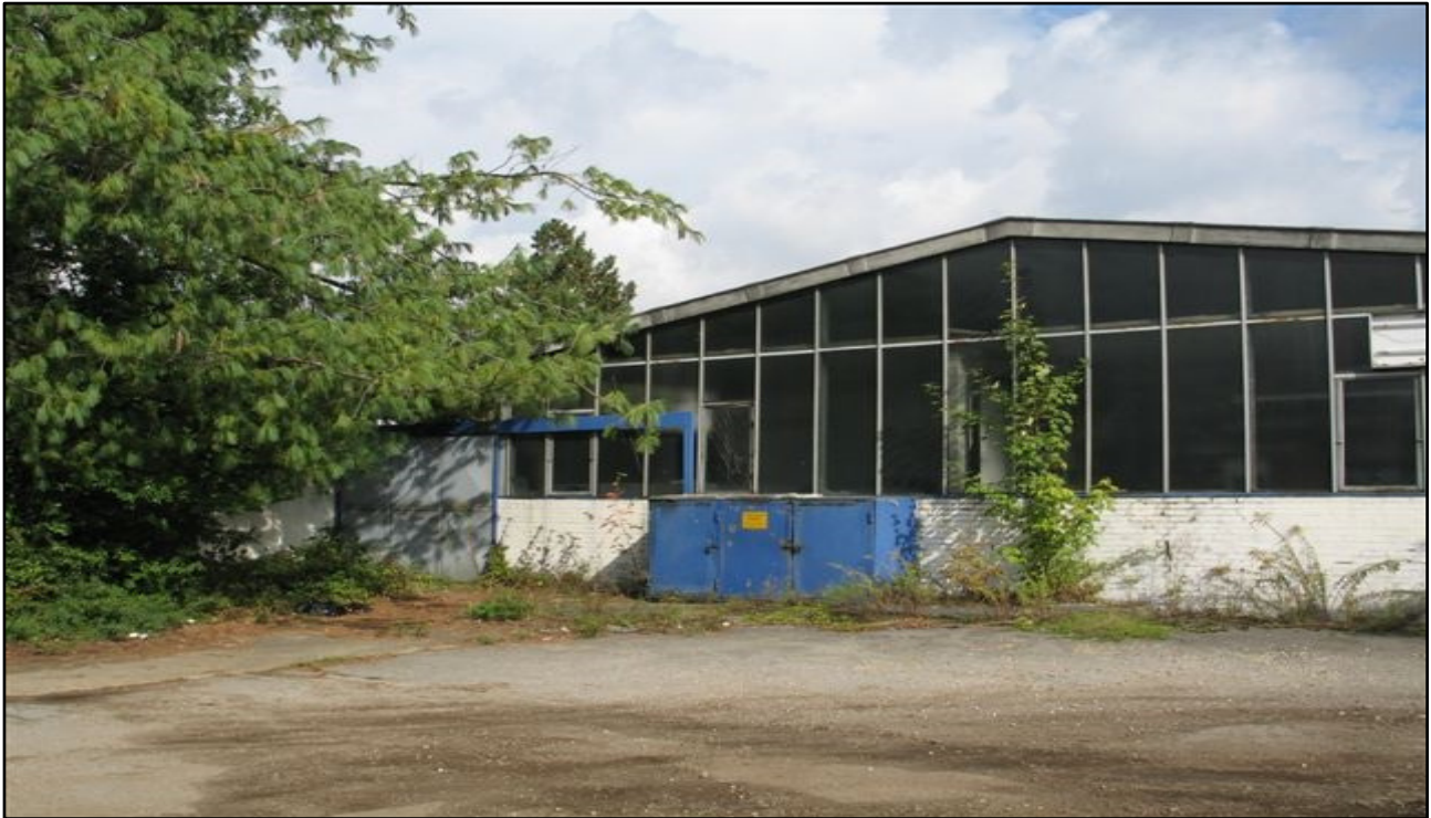
Abbildung 7: Außenansicht des ehemaligen Betriebsgebäudes der Chemischen Reinigung Düren-Gürzenich, Mirweilerweg (Foto: Kreis Düren, Umweltamt 2012)
