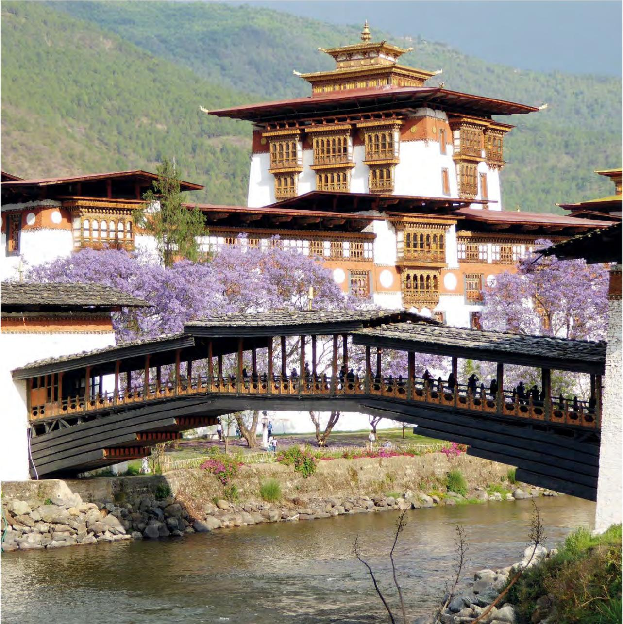
*Foto: Die außergewöhnliche 55 Meter weit gespannte und als Hybridbrücke errichtete Bazam zum Punakha-Kloster*
