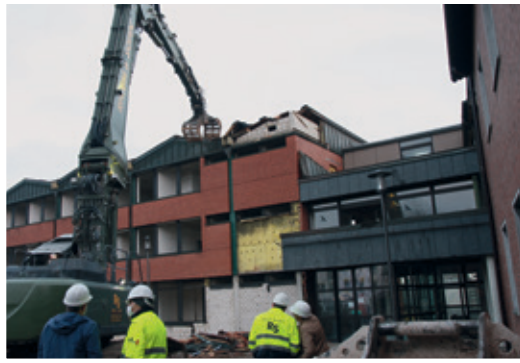
Der Bagger rückt an: Beginn der BürgerMitte Baesweiler
