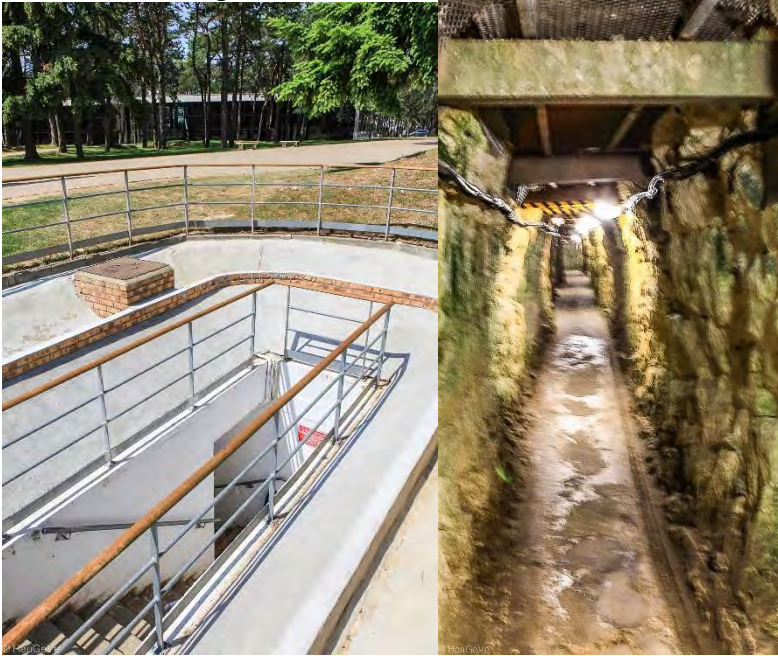
Bild 7 und 8 Eingang zum Tunnelsystem; enge nasskalte Tunnel
