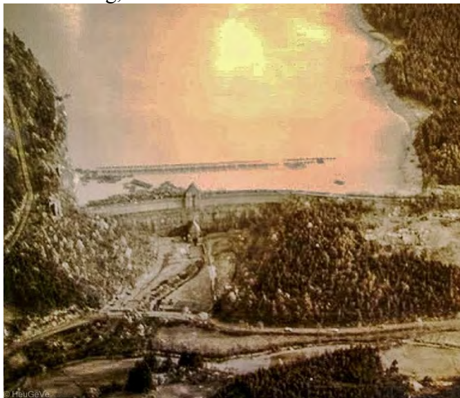
Torpedonetz und der Tarnanstrich an der Sperrmauer in Roetgen, 1943
