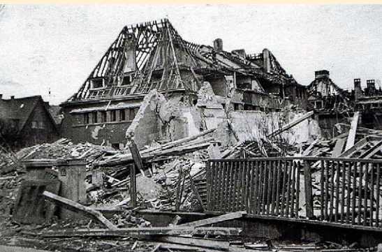
Zerstörtes Haus Garthestraße 3
