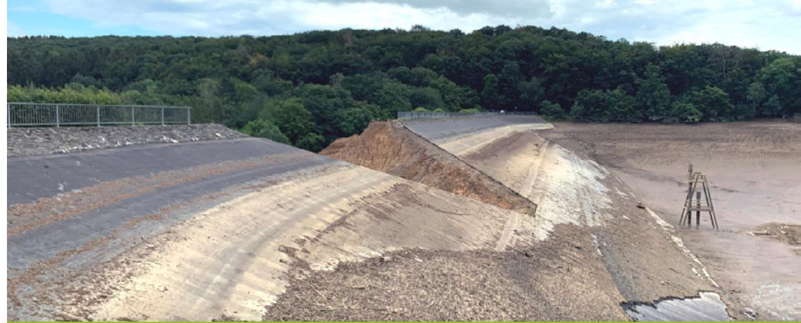
Der Damm der 1966 gebauten Steinbachtalsperre muss saniert werden. Deshalb wurde das Wasser fast komplett abgelassen. © M. Martin
