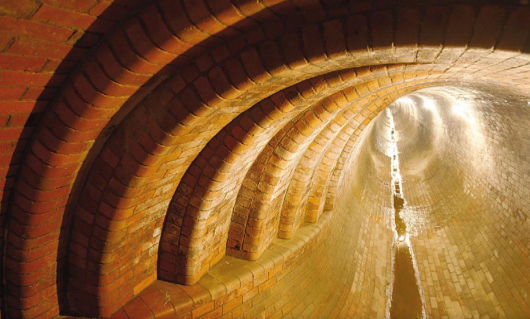
Vollständig mit Backsteinen ausgekleidetes Kurven-Teilstück einer unterirdischen Kanalisation mit Beleuchtung, führt wenig Abwasser © iStock.com / Chalabala
