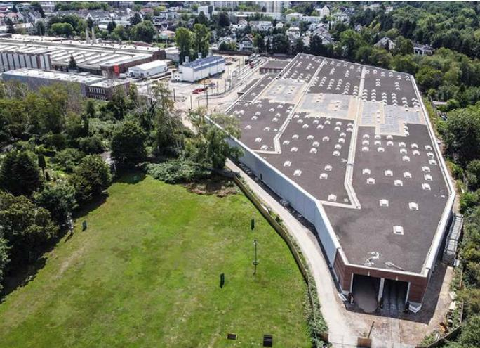
17.500 Quadratmetern eine Abstellanlage mit „Rundum-Betreuung“ für Menschen und Material entstanden. Zum Neubau gehören eine große, dreigliedrige Abstellhalle mit 16 Gleisen, die Platz für insgesamt 64 Stadtbahnwagen bietet, das sind 32 Doppelzüge, sowie eine Besandungsanlage für Brems sand und
