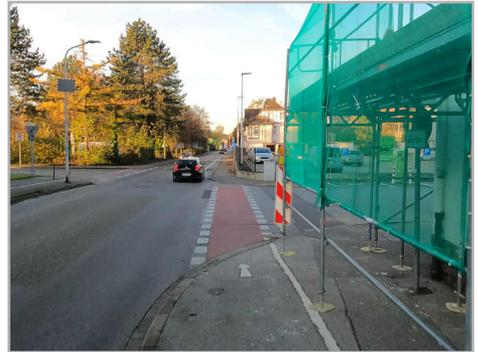
**Abb. 21: Verschwenkung auf Schutzstreifen, mit Vorfahrt für den motorisierten Verkehr**
