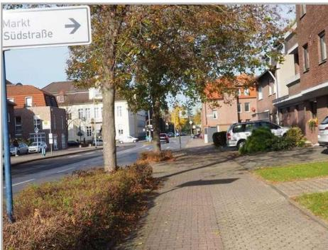
Abb. 8: Absenkung an jeder Grundstückseinfahrt
