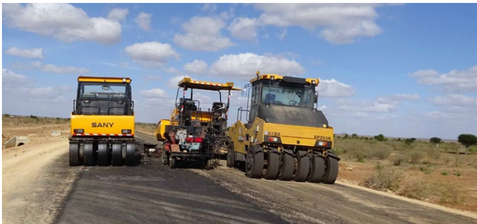
Im Bau befindliche Straße
