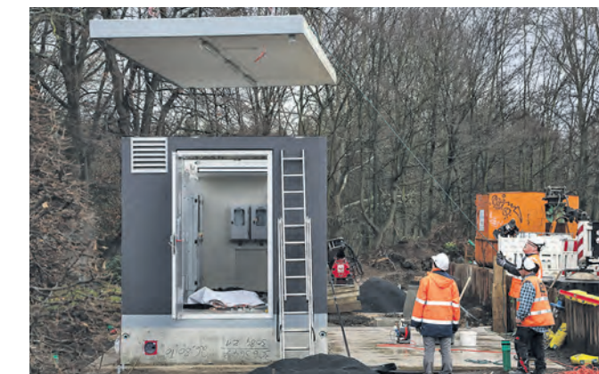
Aufbau einer neuen Ladestation
