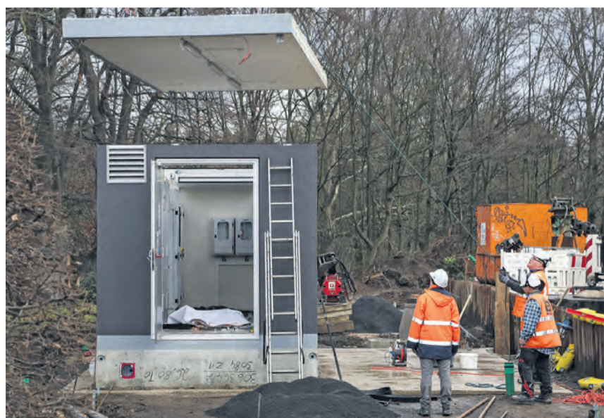
Montage einer Betonzelle an der Ladestation
