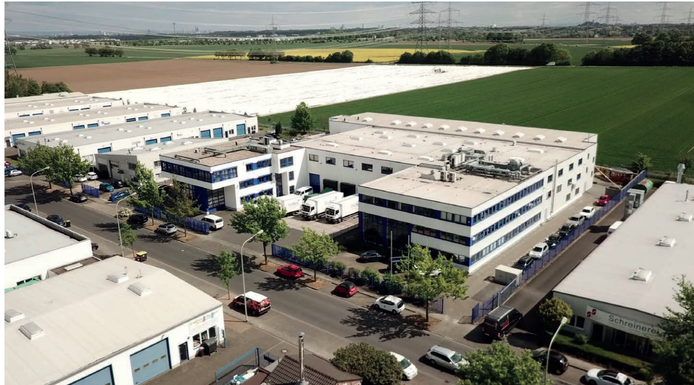
Das Versorgungszentrum der ProServ Rhein-Erft GmbH in Brauweiler aus der Luft.
