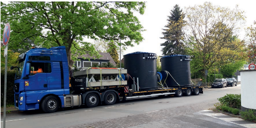
Bild 3.4: Anlieferung der Dosierschächte per Tieflader im Mai 2021
