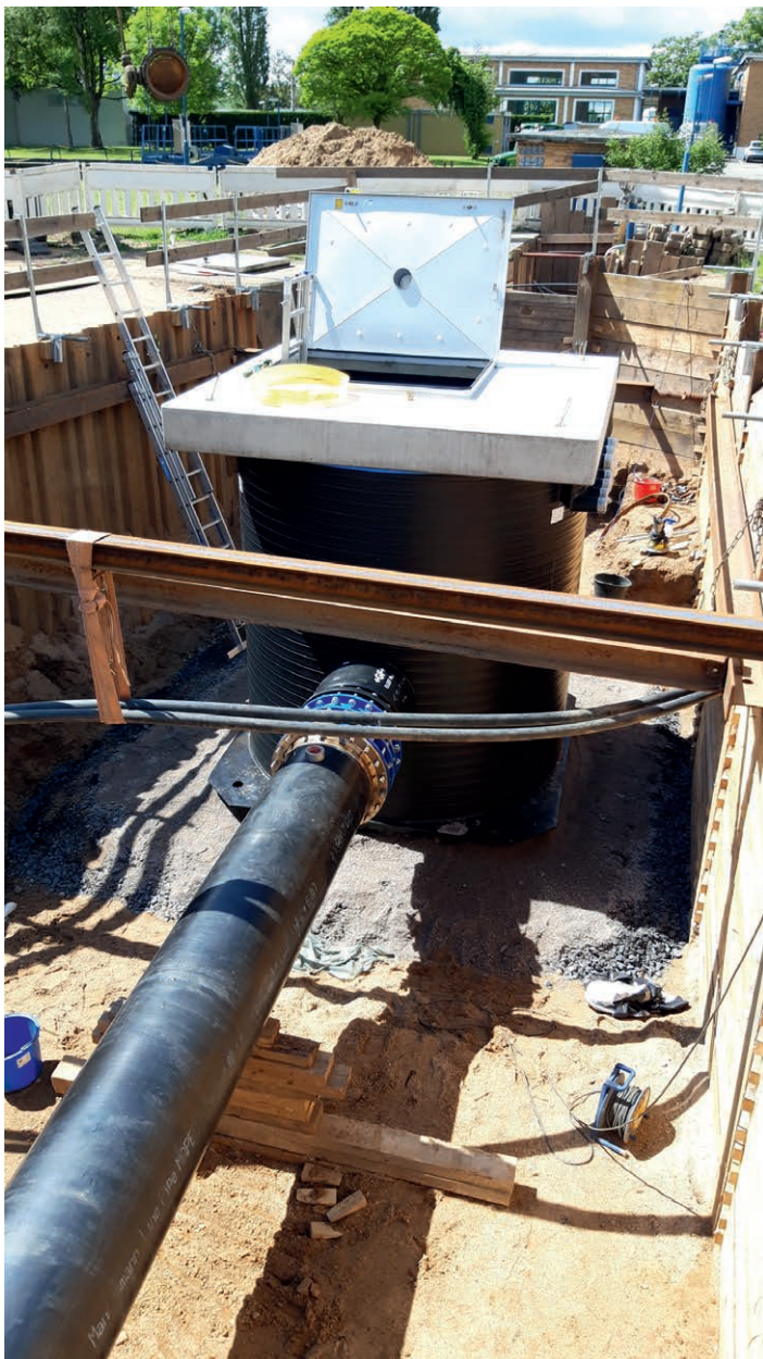
Bild 3.5: Baugrube mit Dosierschacht an Strang A
