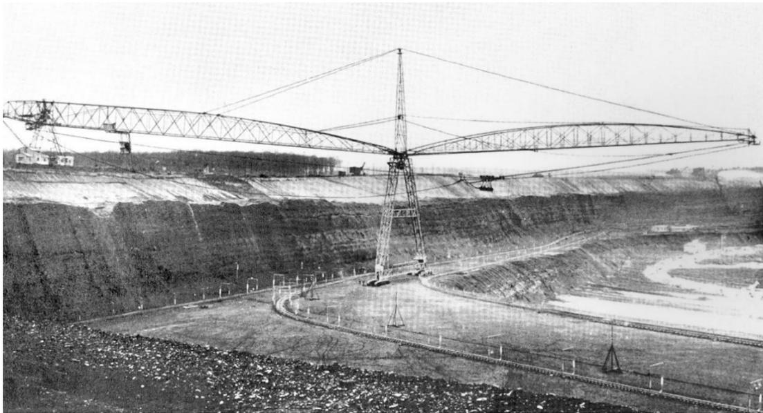
Bild 14: Brückenkabelbagger im Tagebau Vereinigte Ville<sup>26</sup>
