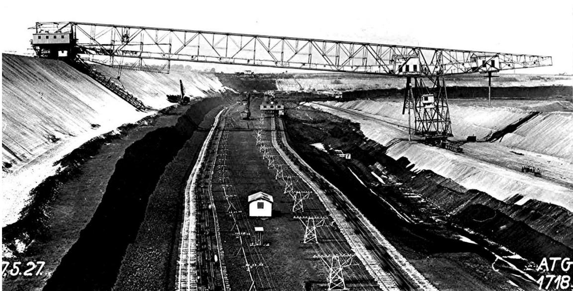
Bilder 5 (oben) und 6 (unten): Die Förderbrücke in der Grube Neurath<sup>8 9</sup>
