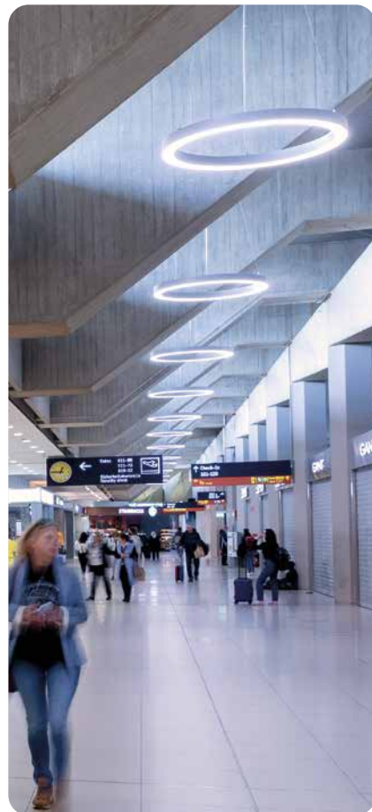
Neue LED-Leuchten im Terminal.
